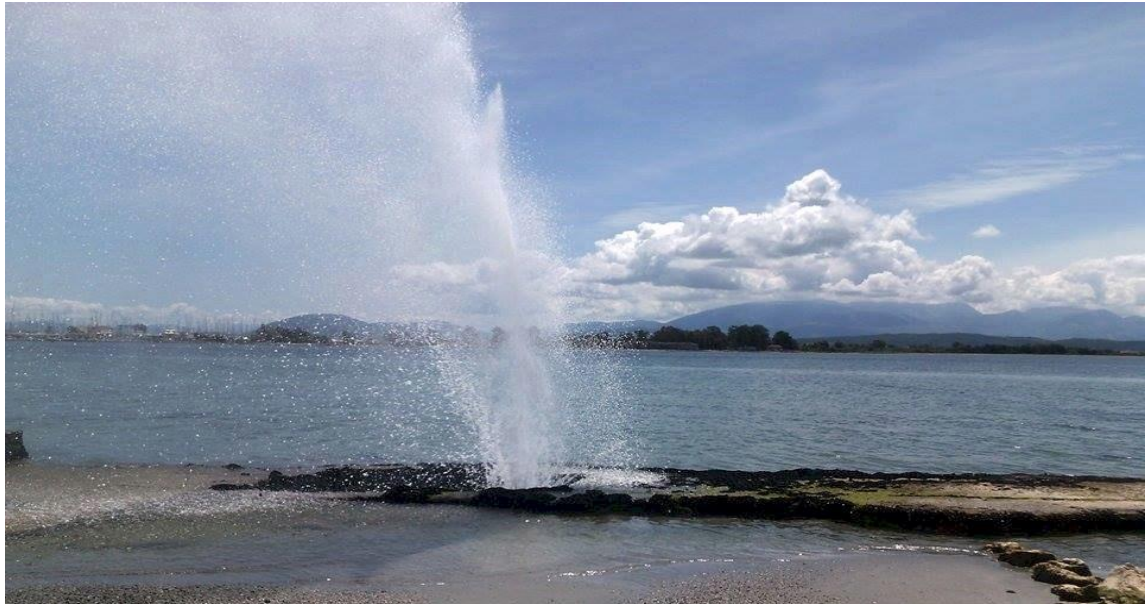
Εικόνα 1:Σπάσιμο του κεντρικού αγωγού που τροφοδοτεί με νερό τη Λευκάδα. (Πηγή: www.kolivas.de )
