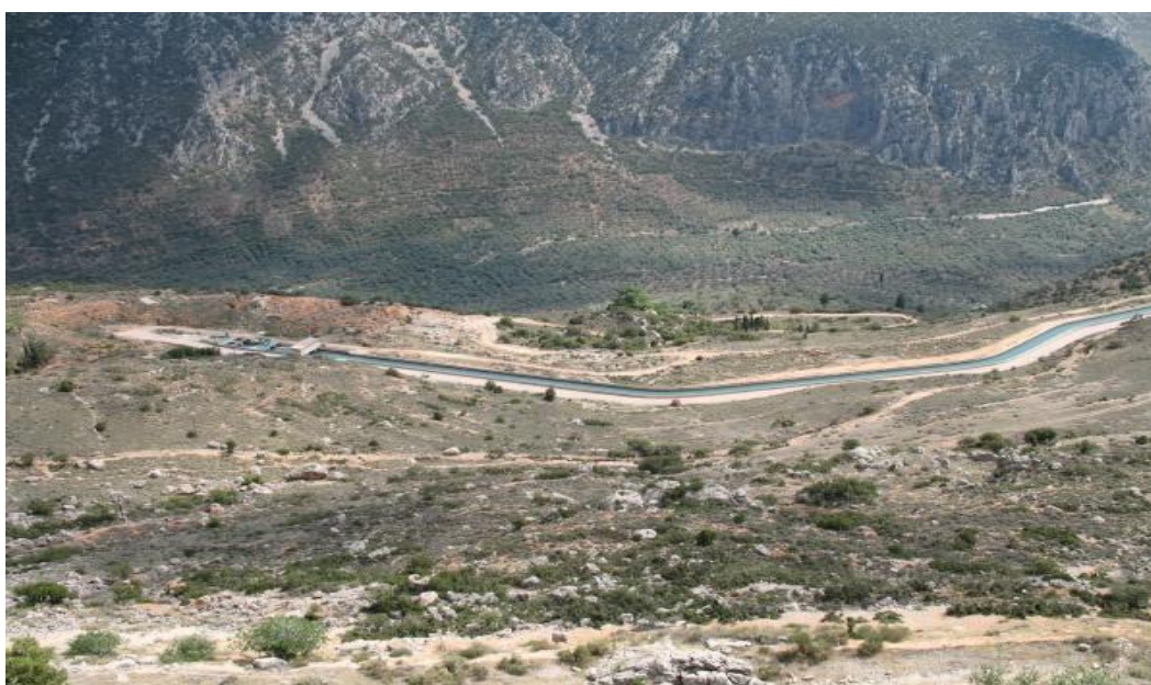
Εικόνα 10.Υδραγωγείο Μόρνου (Πηγή: www.wikimapia.org )
