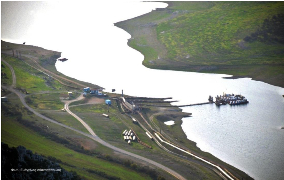
Εικόνα 7. Πλωτό αντλιοστάσιο της ΕΥΔΑΠ στην Υλίκη Βοιωτίας. (Πηγή: www.orchomenos.gr )
