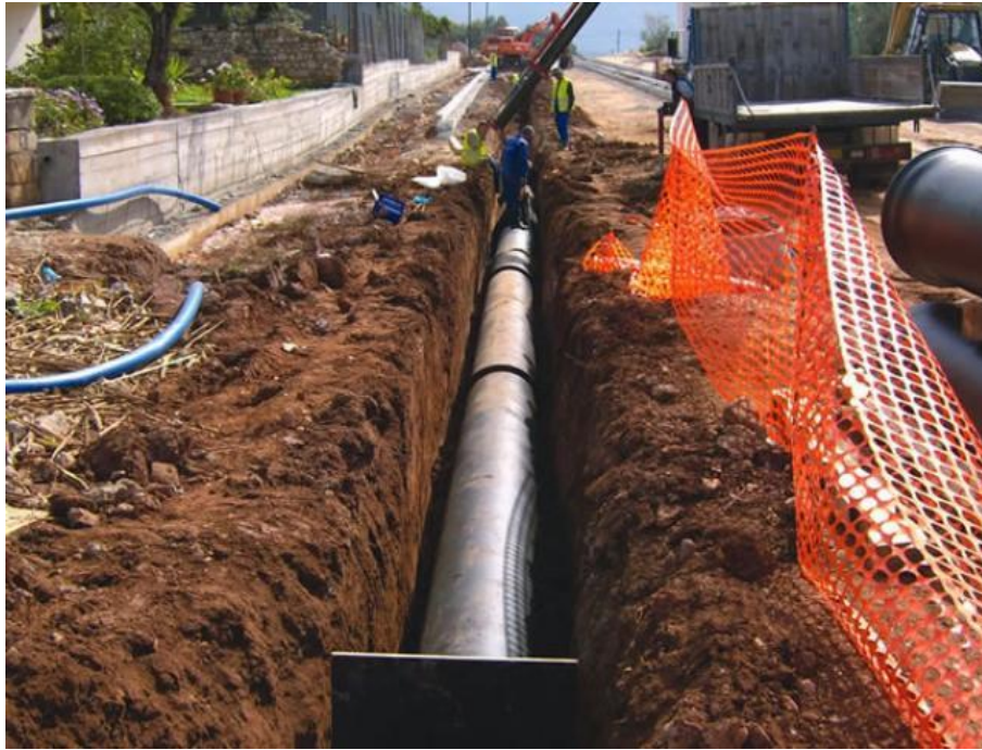
Εικόνα 5: Αντικατάσταση αγωγών ύδρευσης από αμίαντο στην Καλαμάτα (Πηγή: www.tharrosnews.gr )
