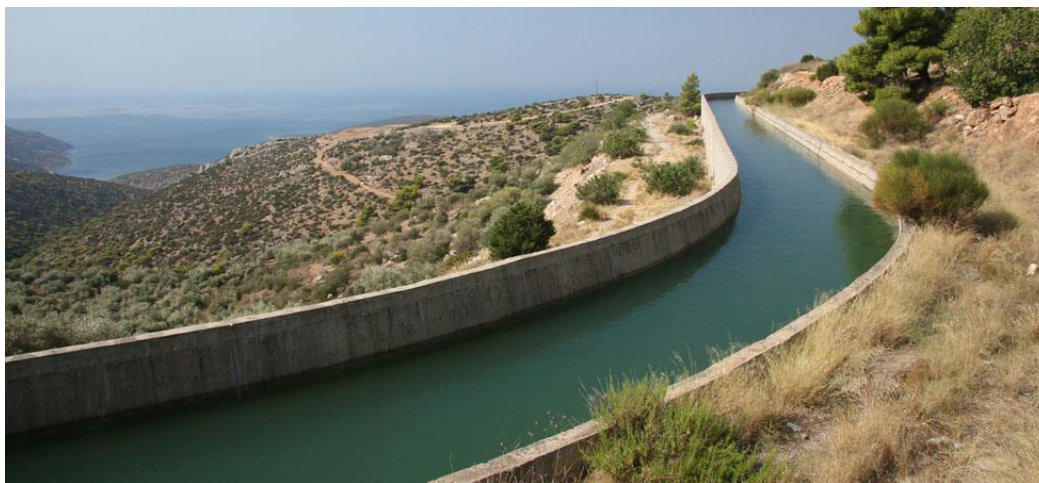
Εικόνα 9. Το υδραγωγείο του Μόρνου (που βλέπουμε εδώ στο ύψος του χωριού Πρόδρομος, στη Βοιωτία) είναι το δεύτερο μεγαλύτερο υδραγωγείο στην Ευρώπη, με μήκος 192 km., Φωτ.: Νίκος Λουπάκης) (Πηγή: www.pemptousia.gr )
