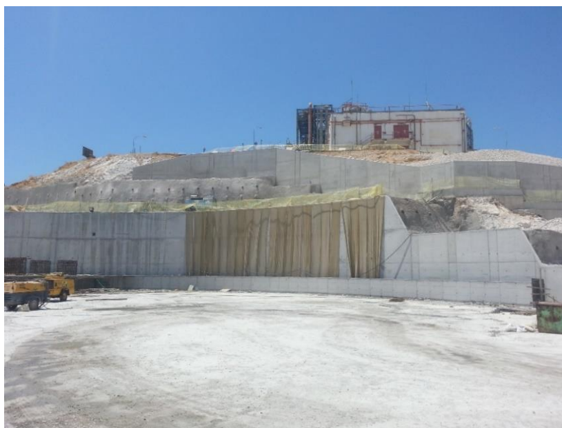
Σχημα 1.1: Εικόνα τμήματος δεξαμενής και τοίχου αντιστήριξης
