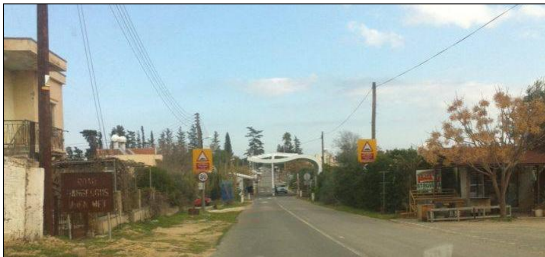
Εικόνα 5.5: Οδόφραγμα Στροβιλιών Πηγή: Μελετητής
