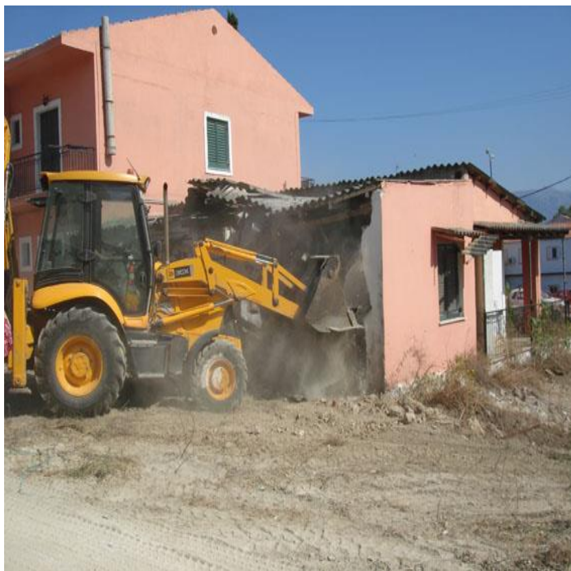
Εικόνα 4.8: Κατεδάφιση αυθαιρέτου κτίσματος
