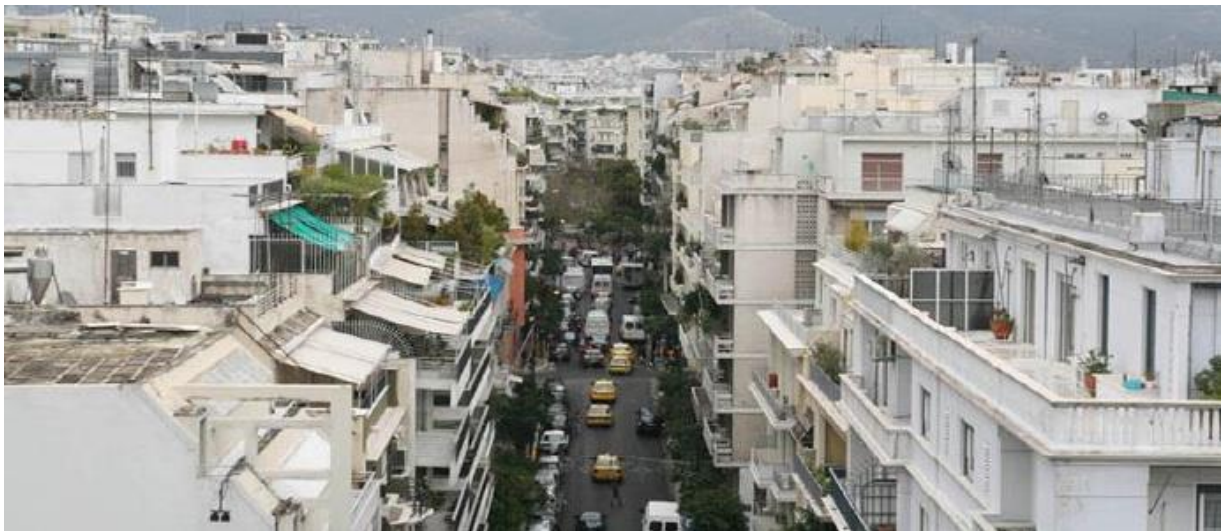
Εικόνα 5.1: Εικόνες της Αθήνας όπου φαίνονται οι επιπτώσεις της αυθαίρετης δόμησης
