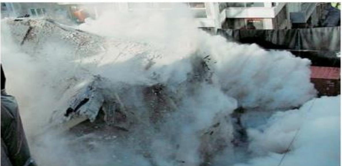
Εικόνα 4.10: Κατεδαφίσεις αυθαίρετων κατασκευών με διαφορετικά μέσα
