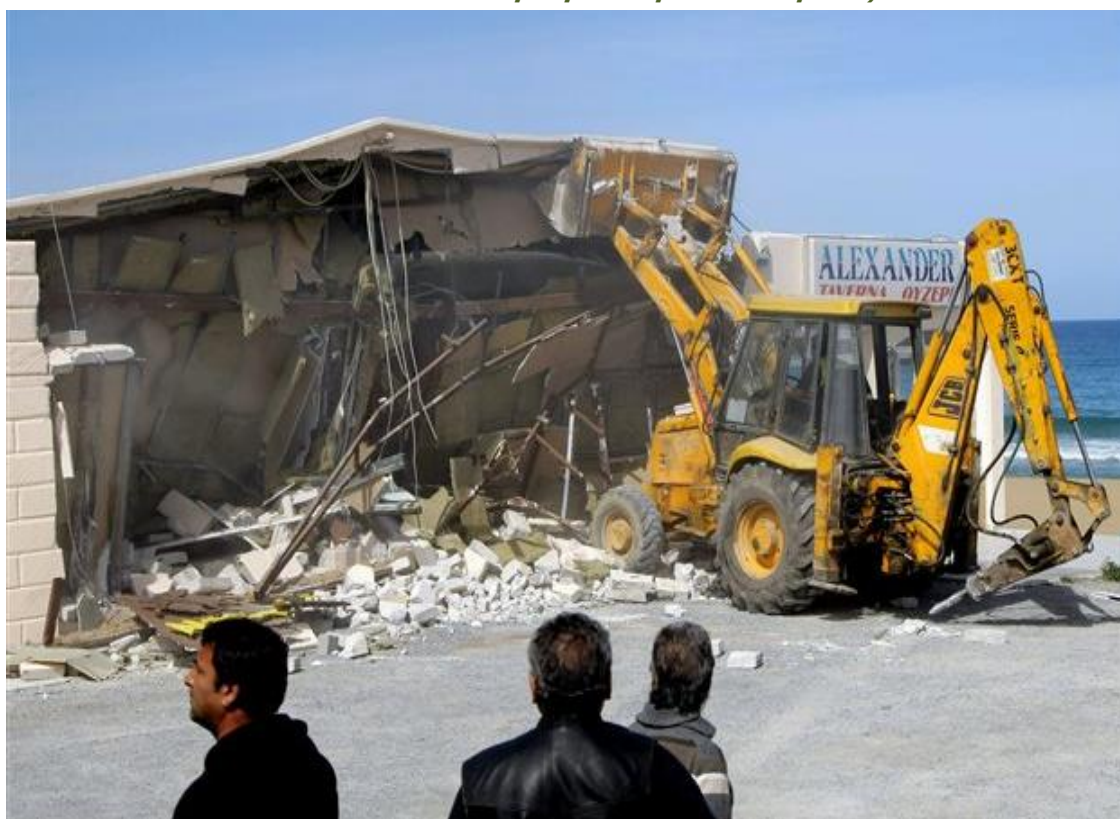
Εικόνα 4.9: Κατεδάφιση αυθαιρέτης κατασκευής σε αιγιαλό
