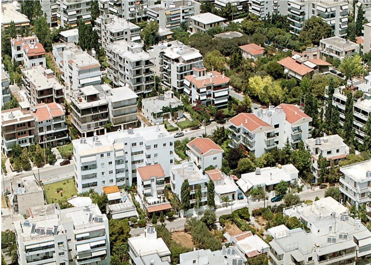
Εικόνα 2.6: Πολυκατοικίες που δημιουργήθηκαν με το σύστημα της αντιπαροχής στο Παλιό Φάληρο
