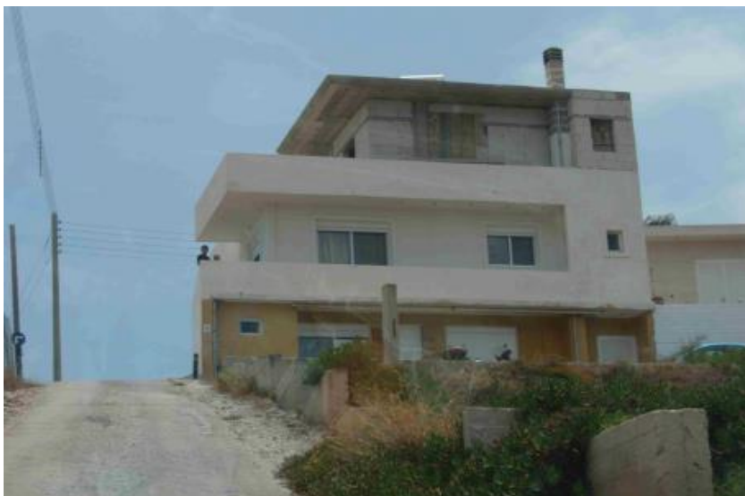
Εικόνα 3.1: Παράνομη κατασκευή 3 ου ορόφου στην περιοχή της Κερατέας
