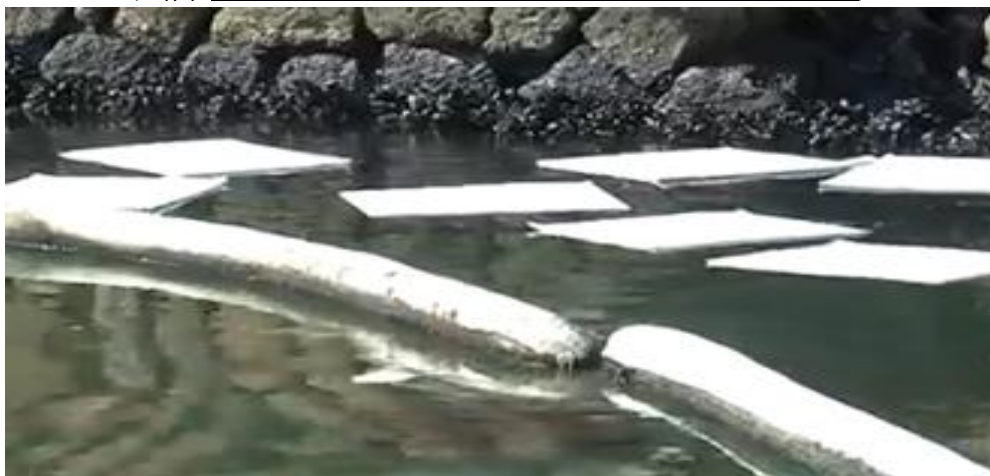
Εικόνα 3.11: Χρήση απορροφητικών υλικών απορρύπανσης πετρελαιοκηλίδας. (Πηγή: http://www.e-evros.gr/index.php?sec=85&cid=19814 )
