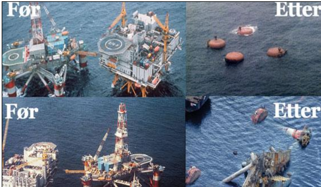
Εικόνα 3.26: Η πλατφόρμα Alexander L. Kielland πριν (αριστερά) και μετά (δεξιά) το ατύχημα. (Πηγή: http://balderconsultancy.com/about.html )
