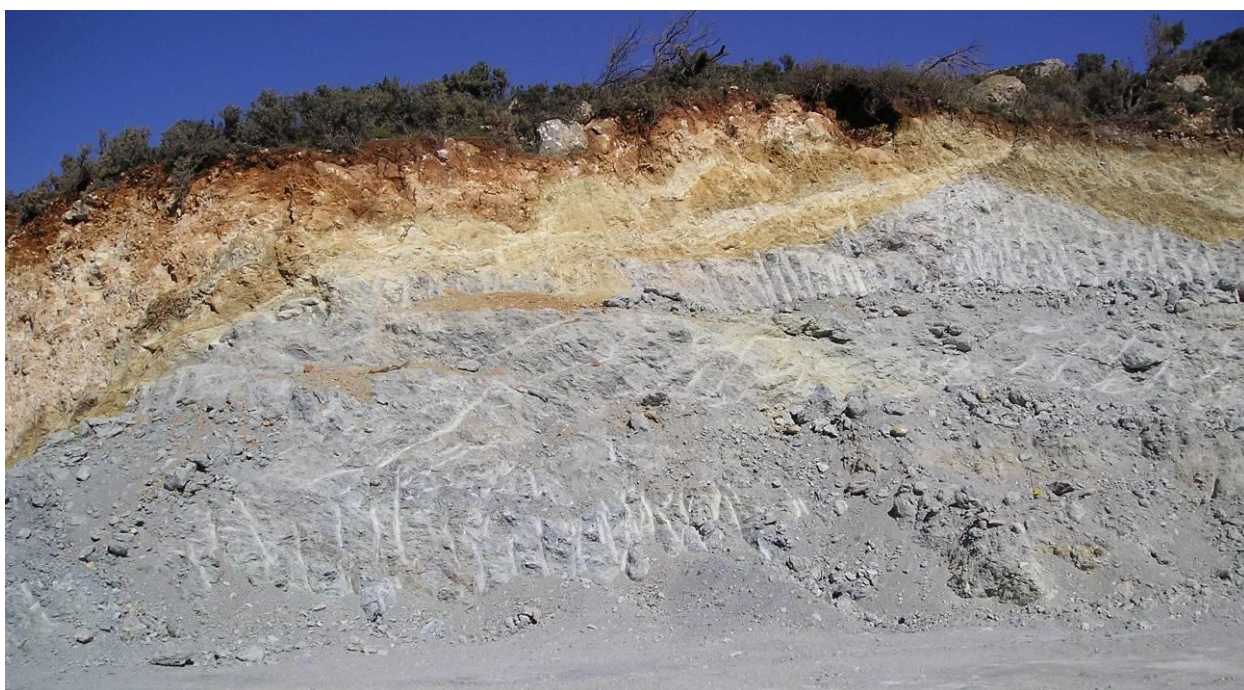
Φωτογραφία 15.5. Δύο όψεις στις εκσκαφές στο δεξιό αντέρεισμα του φράγματος Φερεκάμπου όπου διακρίνεται βραχώδες κάλυμμα του αποσαθρωμένου σερπεντινίτη αποτελούμενο από ασβεστολίθους και λατυποπαγή.
