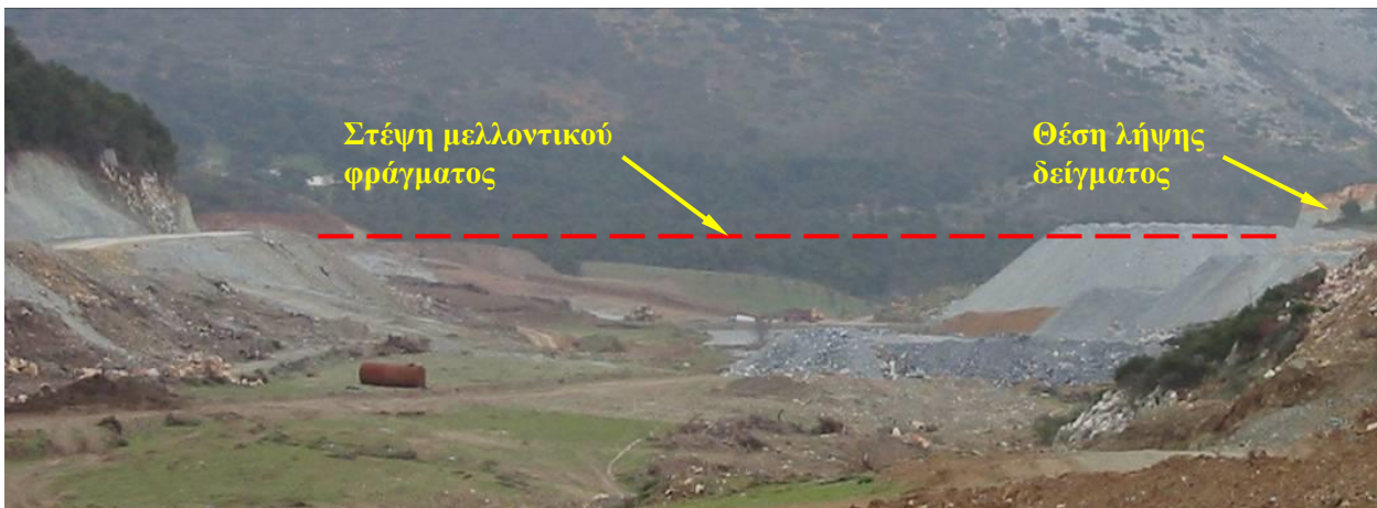
Φωτογραφία 15.1. Γενική άποψη της περιοχής του έργου από ανάντη με τις εμφανίσεις του σερπεντινίτη αλλά και τους χώρους απόθεσης του υλικού που προκύπτει από εκσκαφές για μελλοντική χρήση στην κατασκευή του φράγματος.
