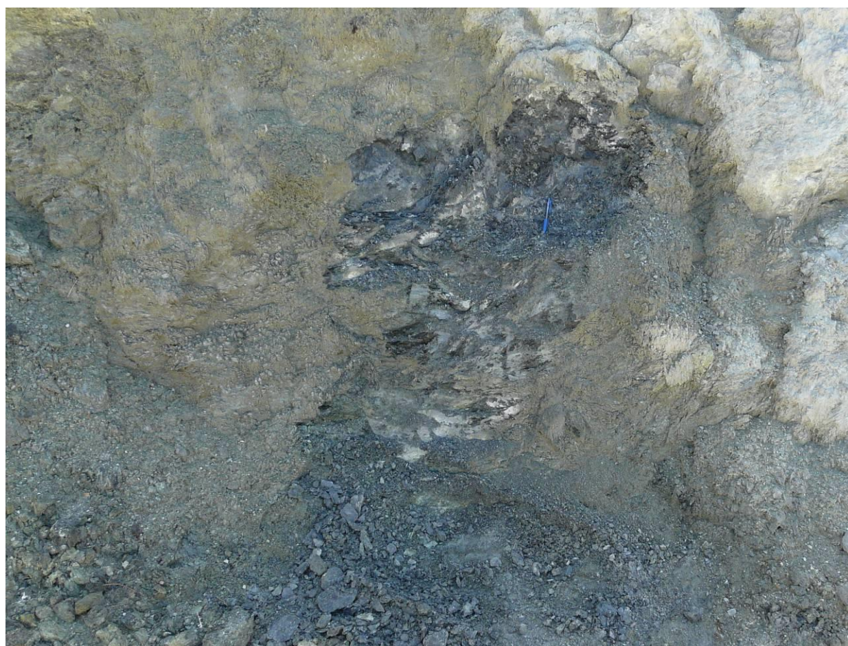
Φωτογραφία 15.6. Γενική άποψη του πρανούς εκσκαφής στο δεξιό αντέρεισμα του φράγματος Φερεκάμπου από όπου ελήφθη το δείγμα και κοντινή άποψη της θέσης δειγματοληψίας.
