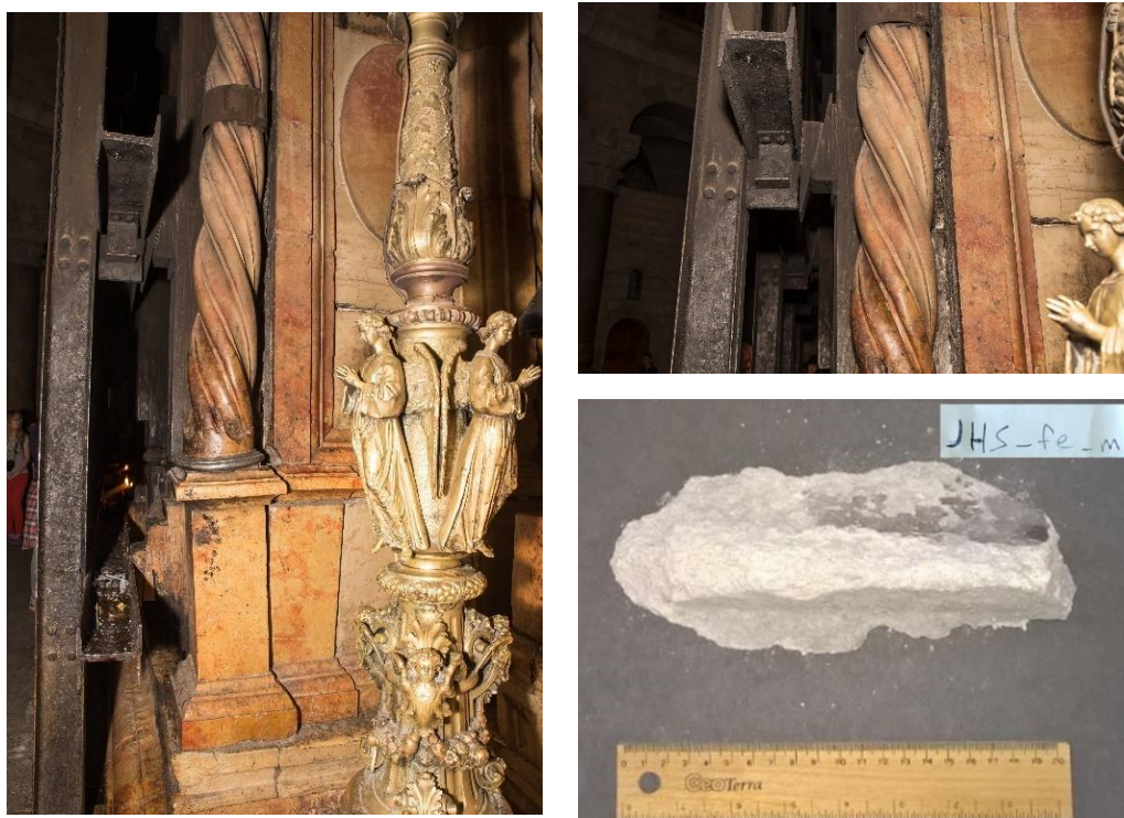
Εικόνα 3.15 Αριστερά: σημείο εξαγωγής δείγματος κονιάματος πλήρωσης Δεξιά: Κονίαμα πλήρωσης σε ανεπεξέργαστη μορφή (κωδικός δείγματος JHS_fe_m)
