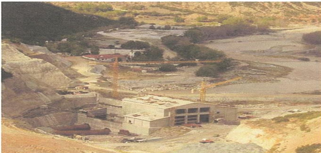
Εικόνα 2-13: Ο υπό κατασκευή υποσταθμός (Σεπτέμβριος 2006) (Πηγή:ΔΕΗ)
