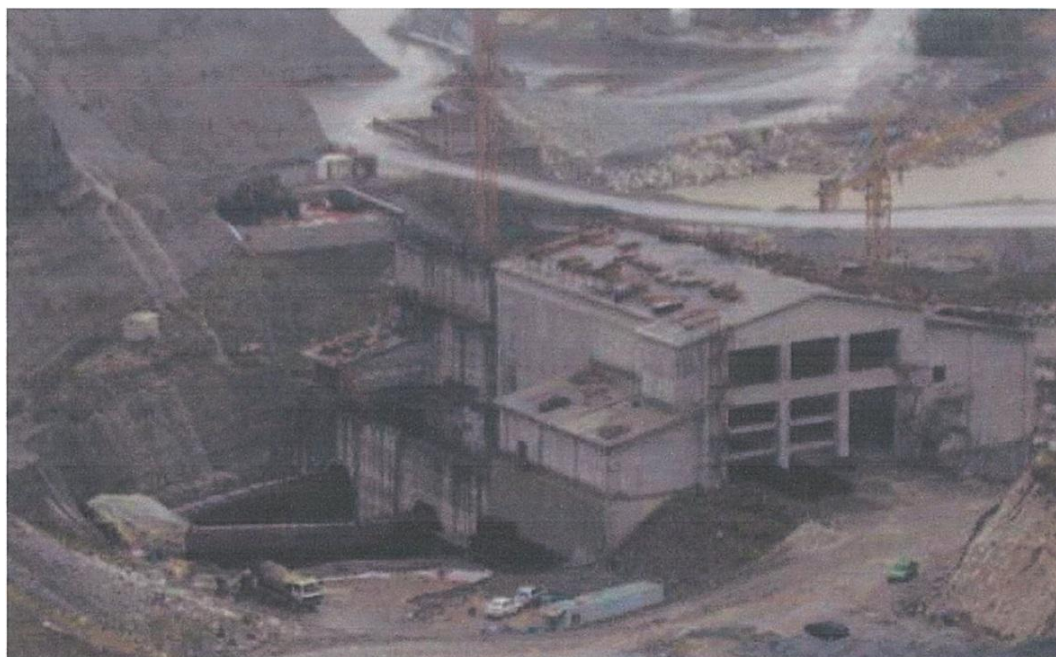
Εικόνα 2-14: Ο υπό κατασκευή υποσταθμός (Σεπτέμβριος 2006) (Πηγή:ΔΕΗ)
