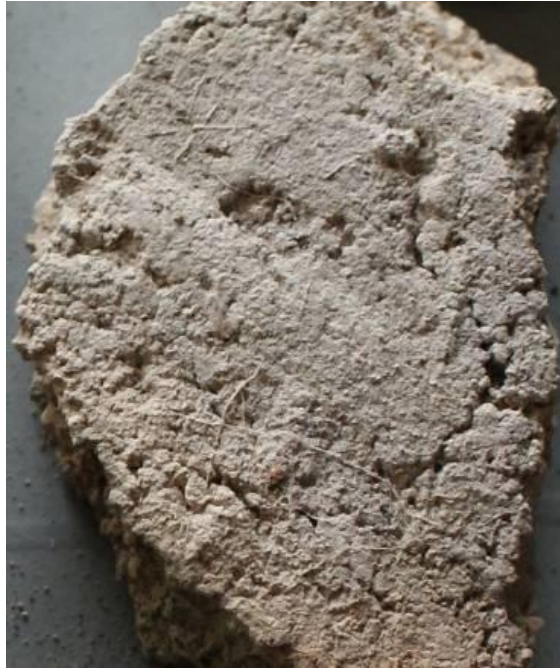
Εικόνα 35. Κονίαμα με ρωγμές και πόρους.
