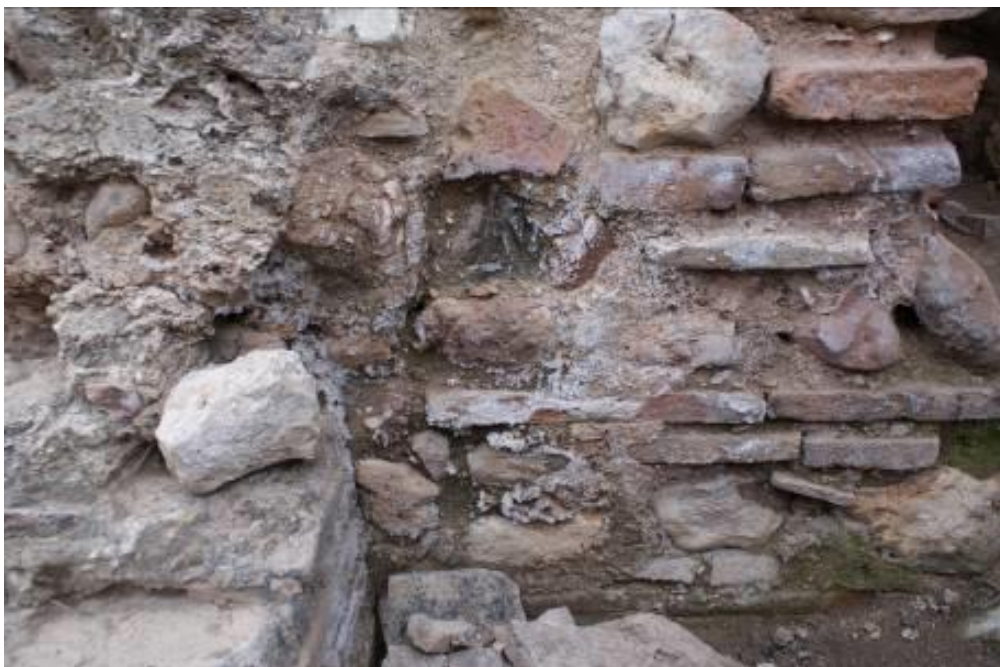
Εικόνα 21. Κρυστάλλωση αλάτων
