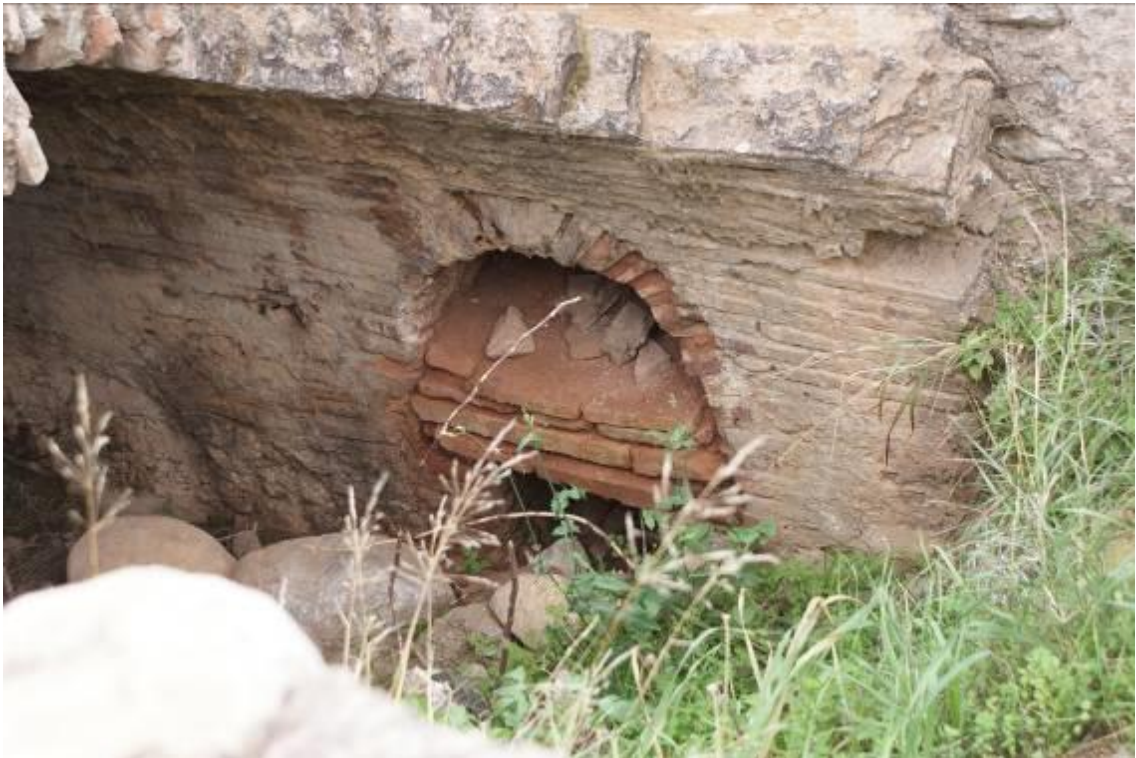
Εικόνα 8. Υπόγεια αίθουσα με υπόκαυστα.
