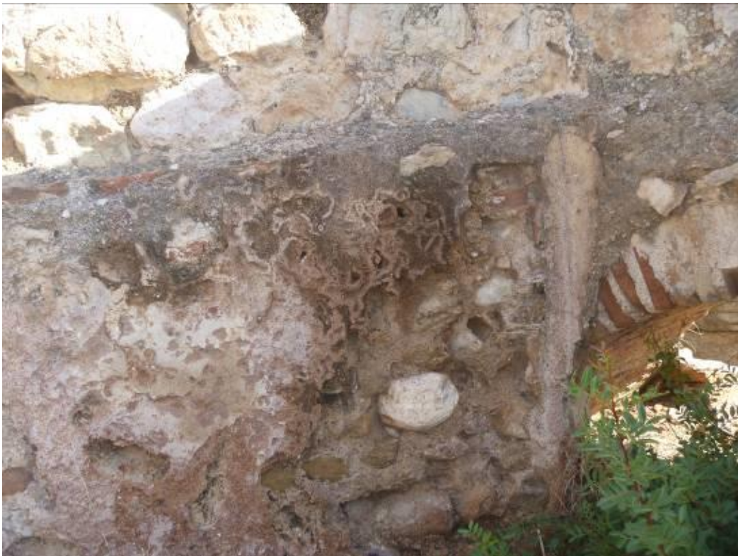
Εικόνα 28. Κατάρρευση επιχρισμάτων.
