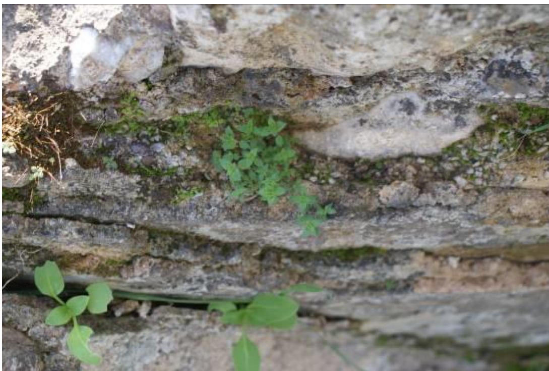
Εικόνα 24. Ανάπτυξη φυτών ανάμεσα στα επιχρίσματα
