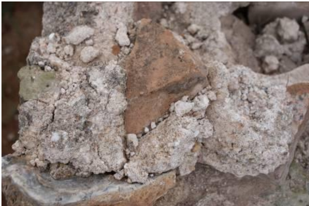
Εικόνα 26. Αποδιοργάνωση κονιαμάτων
