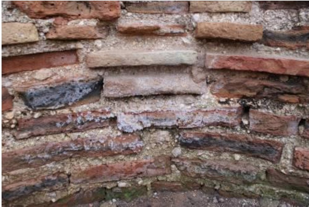
Εικόνα 20. Κρυστάλλωση αλάτων
