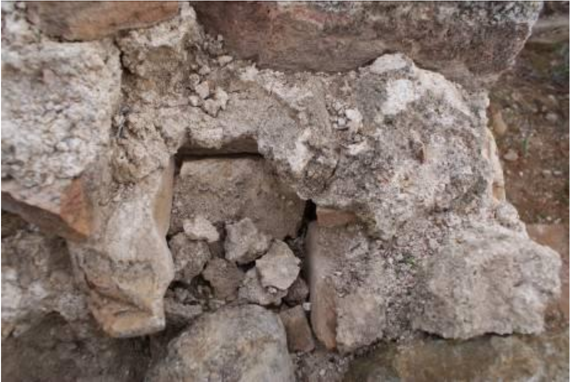
Εικόνα 27. Αποδιοργάνωση κονιαμάτων
