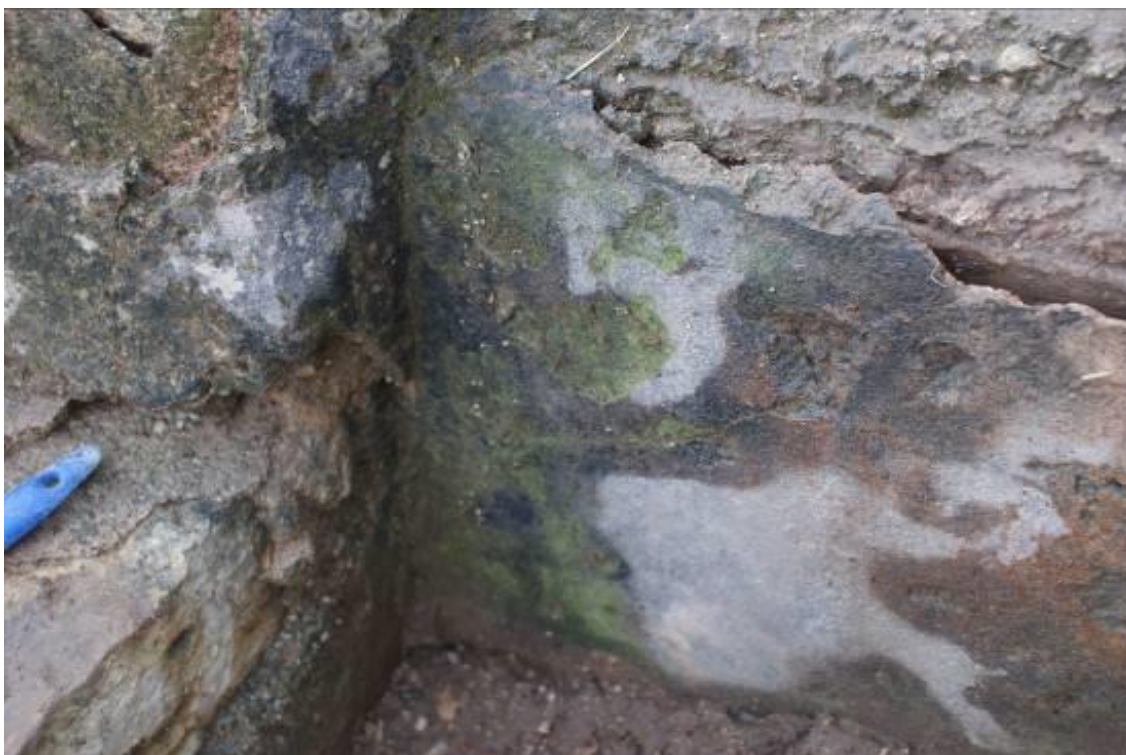
Εικόνα 17. Ανερχόμενη υγρασία.
