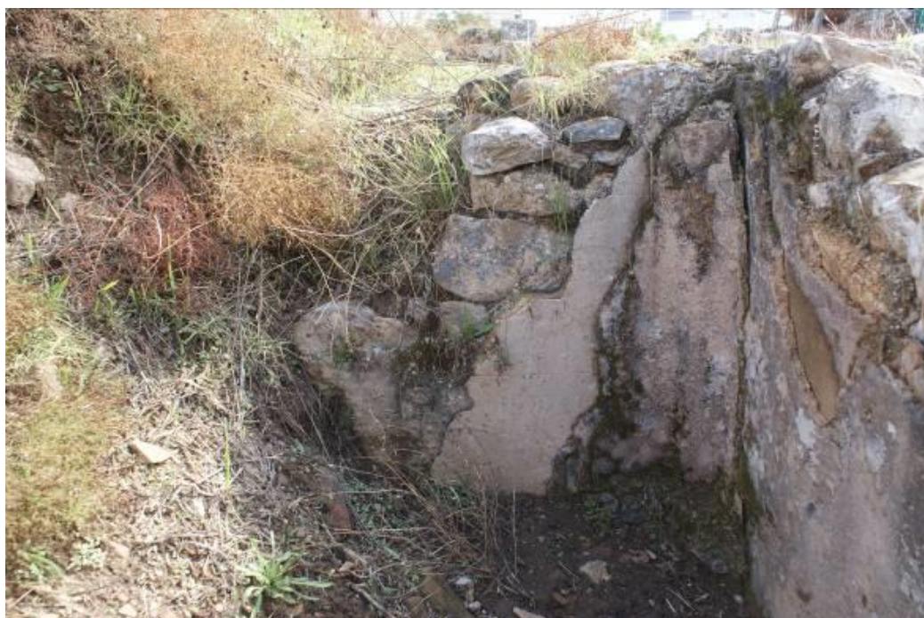
Εικόνα 16. Επίχρισματα στη δεξαμενή στα δυτικά του χώρου.
