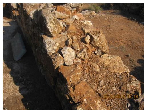
Εικόνα 5.3: όψη και κάτοψη τρίστρωτης τοιχοποιίας: άριστη προσαρμογή μικρότερων λίθων στις εξωτερικές παρειές.
