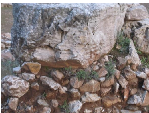
Εικόνα 5.4: τοιχοποιίες χαμηλής ποιότητας δόμηση. Αριστερά: μικροί λίθοι και πλούσιο κονίαμα φέρουν πολύ μεγαλύτερο λίθο. Δεξιά: Μικροί λίθοι και ατελής σύνδεση στις γωνίες.
