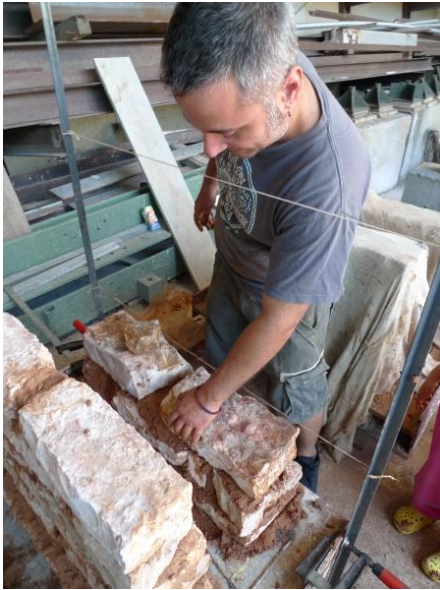
Εικόνες 8.5 και 8.6: Αριστερά(8.5)_Οπτικός έλεγχος με τα ράμματα για τη σωστή τοποθέτηση στο κατακόρυφο επίπεδο. Δεξιά(8.6)_Τοποθέτηση μικρών λίθων στον πυρήνα.
