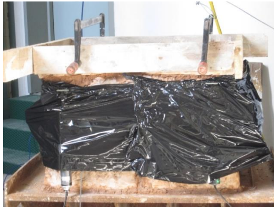
Εικόνα 8.11: ξύλινο καλούπι στο οποίο χύνεται ρευστό γυψοκονίαμα
