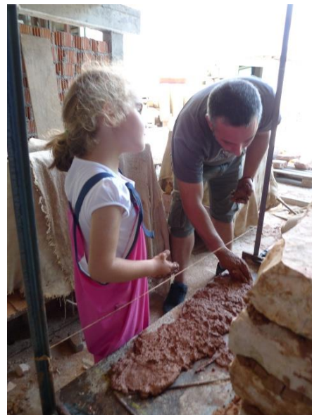
Εικόνες 8.3 και 8.4: Δεξιά(8.4)_ Στρώση κονιάματος ανάμεσα στη μεταλλική λάμα και την πρώτη στρώση λίθων. Αριστερά(8.3)_ Τοποθέτηση μικρού λίθου ανάμεσα στα λιθοσώματα προκειμένου να γεφυρωθεί το κενό.
