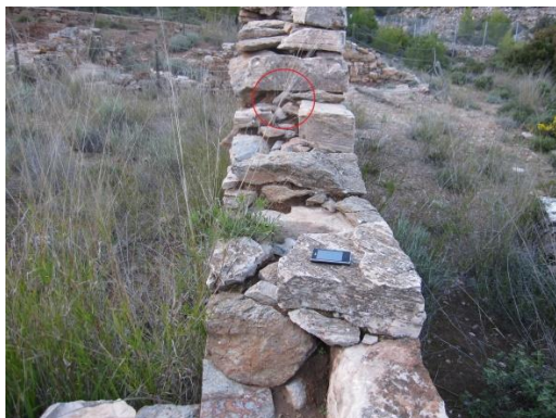
Εικόνα 5.2: δύο εξωτερικές παρειές, μικρότεροι λίθοι και κονίαμα στην ενδιάμεση στρώση, διάτονοι λίθοι.
