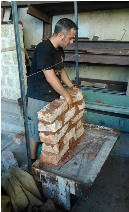
Εικόνα 8.1: πίσω όψη_ τοποθέτηση λίθου
