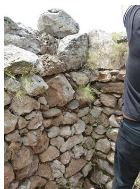
Εικόνα 5.4: τοιχοποιίες χαμηλής ποιότητας δόμηση. Αριστερά: μικροί λίθοι και πλούσιο κονίαμα φέρουν πολύ μεγαλύτερο λίθο. Δεξιά: Μικροί λίθοι και ατελής σύνδεση στις γωνίες.
