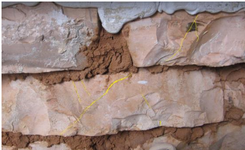
Εικόνες 8.19 και 8.20: εμφάνιση ρωγμών Αριστερά (8.19) στην πλευρά Π1 και Δεξιά (8.20) στην Π2
