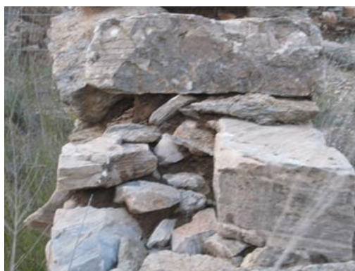
Εικόνα 5.2: δύο εξωτερικές παρειές, μικρότεροι λίθοι και κονίαμα στην ενδιάμεση στρώση, διάτονοι λίθοι.
