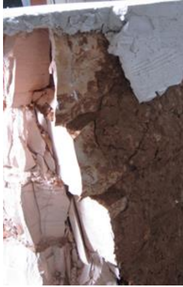
Εικόνα 8.33: Κατακόρυφη αποκόλληση τμημάτων λίθου πιθανότατα λόγω εγκάρσιου εφελκυσμού σε συνδυασμό με θλιπτική φόρτιση.
