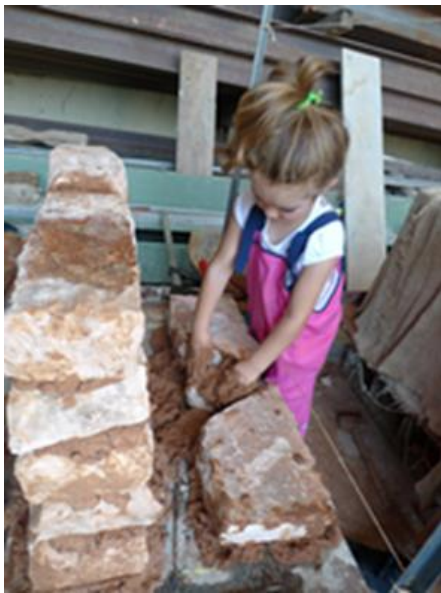
Εικόνες 8.3 και 8.4: Δεξιά(8.4)_ Στρώση κονιάματος ανάμεσα στη μεταλλική λάμα και την πρώτη στρώση λίθων. Αριστερά(8.3)_ Τοποθέτηση μικρού λίθου ανάμεσα στα λιθοσώματα προκειμένου να γεφυρωθεί το κενό.
