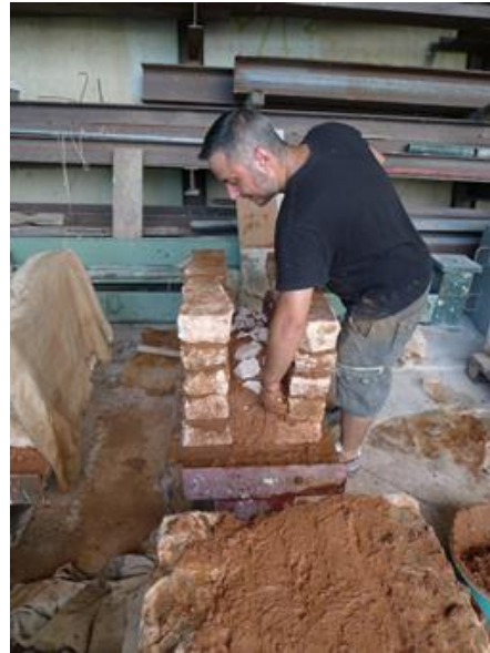
Εικόνες 8.5 και 8.6: Αριστερά(8.5)_Οπτικός έλεγχος με τα ράμματα για τη σωστή τοποθέτηση στο κατακόρυφο επίπεδο. Δεξιά(8.6)_Τοποθέτηση μικρών λίθων στον πυρήνα.
