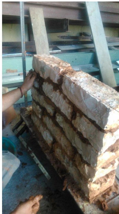
Εικόνα 8.2: μπροστά όψη_ απομάκρυνση περίσσειας κονιάματος
