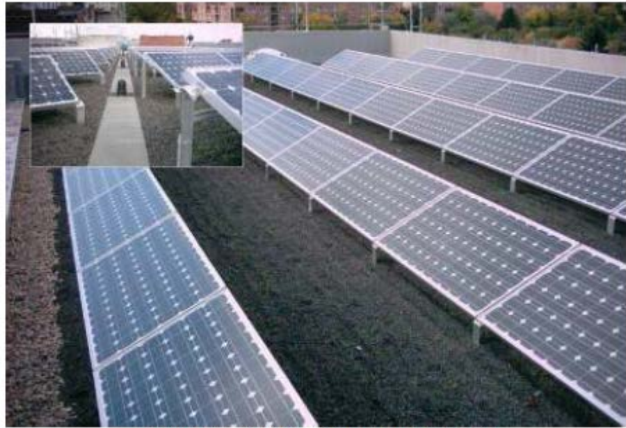
Παράδειγμα τοποθέτησης βάσεων επί στέγης
