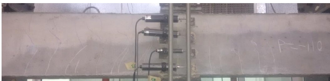
Εικόνα 3.27: Η ρηγμάτωση της δοκού Δ5 στο χώρο του μέσου του μεγάλου ανοίγματος της δοκού Δ5 στο φορτίο -110 kN, στην 1 η ανακύκλιση της 2 \cdot \delta_y
