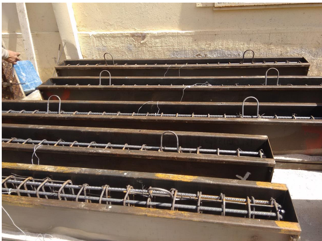
Εικόνα 3.2: Οι μετάλλοτυποι των δοκών πριν την σκυροδέτηση
