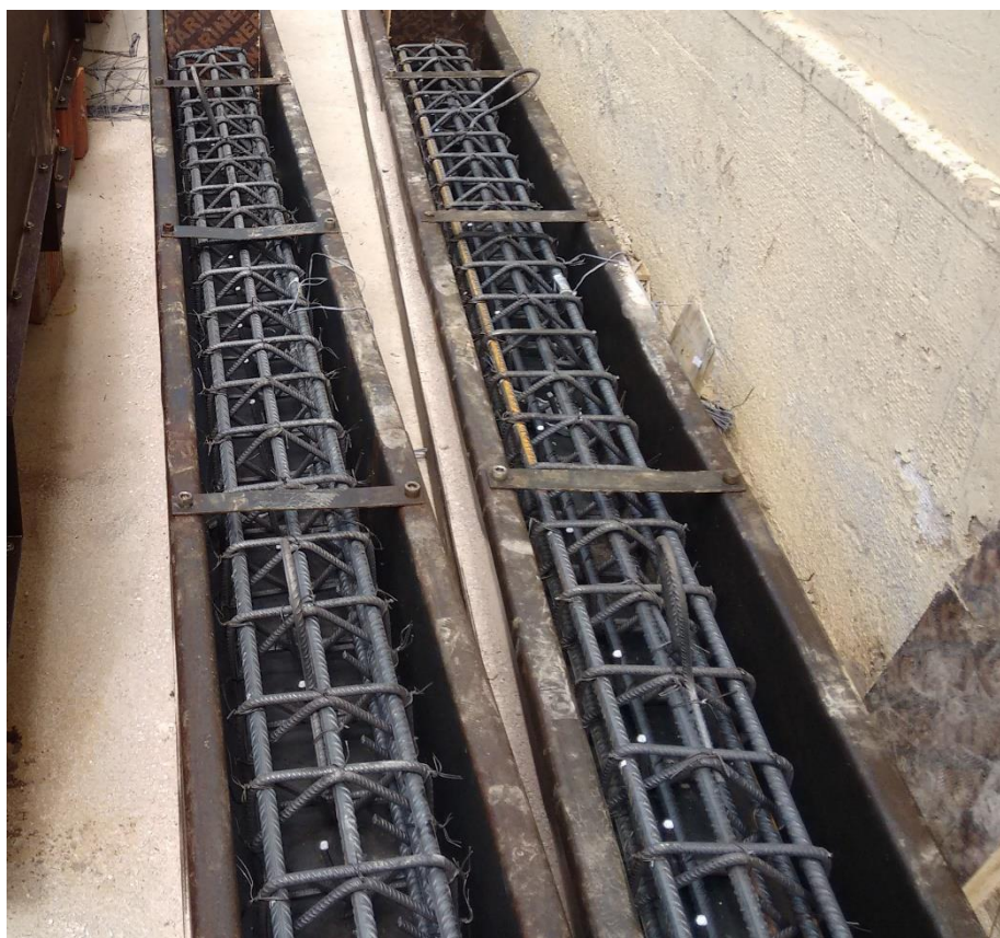
Εικόνα 3.5: Οι μεταλλότυποι των υποστυλωμάτων πριν την σκυροδέτηση
