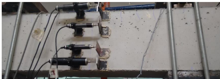
Εικόνα 3.7: Μικρορηγματώσεις στο άνω τμήμα της δοκού λόγω υπέρβασης της ροπής ρηγματώσης
