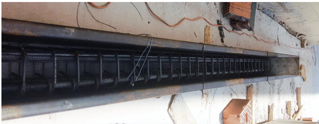
Εικόνα 3.4: Ο μεταλλότυπος της δοκού πριν την σκυροδέτηση
