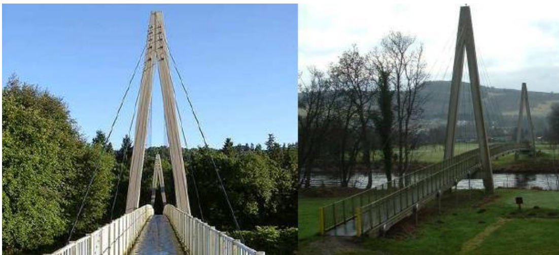
Εικόνες 2.30 και 2.31: Δύο όψεις της πεζογέφυρας Aberfeldy πάνω από τον ποταμό Τάι στη Σκωτία.
