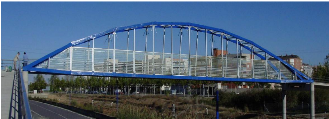
Εικόνα 2.34: Η γέφυρα Lleida στην Ισπανία.
