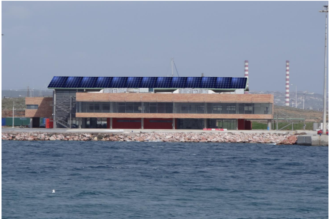
{Εικ. 3.12} Στέγη Λιμεναρχείου με φωτοβολταικά πλαίσια
