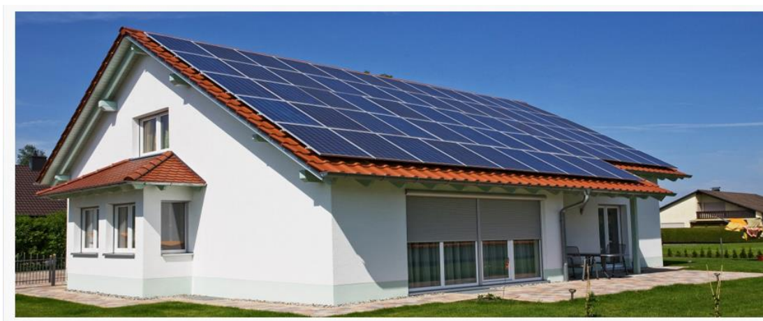
{Εικ. 2.16} Φωτοβολταϊκό σύστημα
