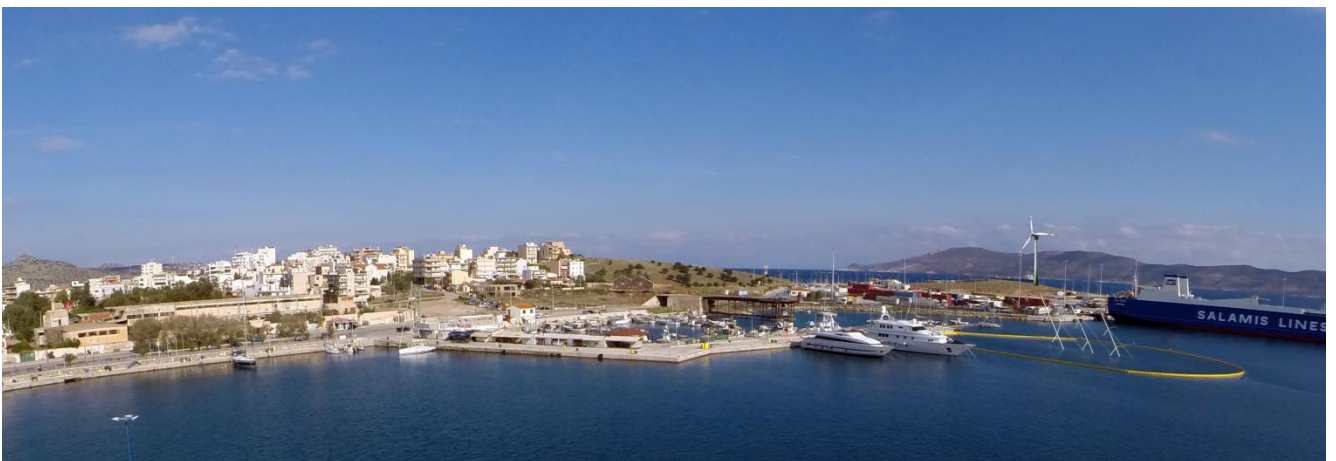
{Εικ. 3.89} Ανεμογεννήτρια και τοπίο λιμένας Λαυρίου
