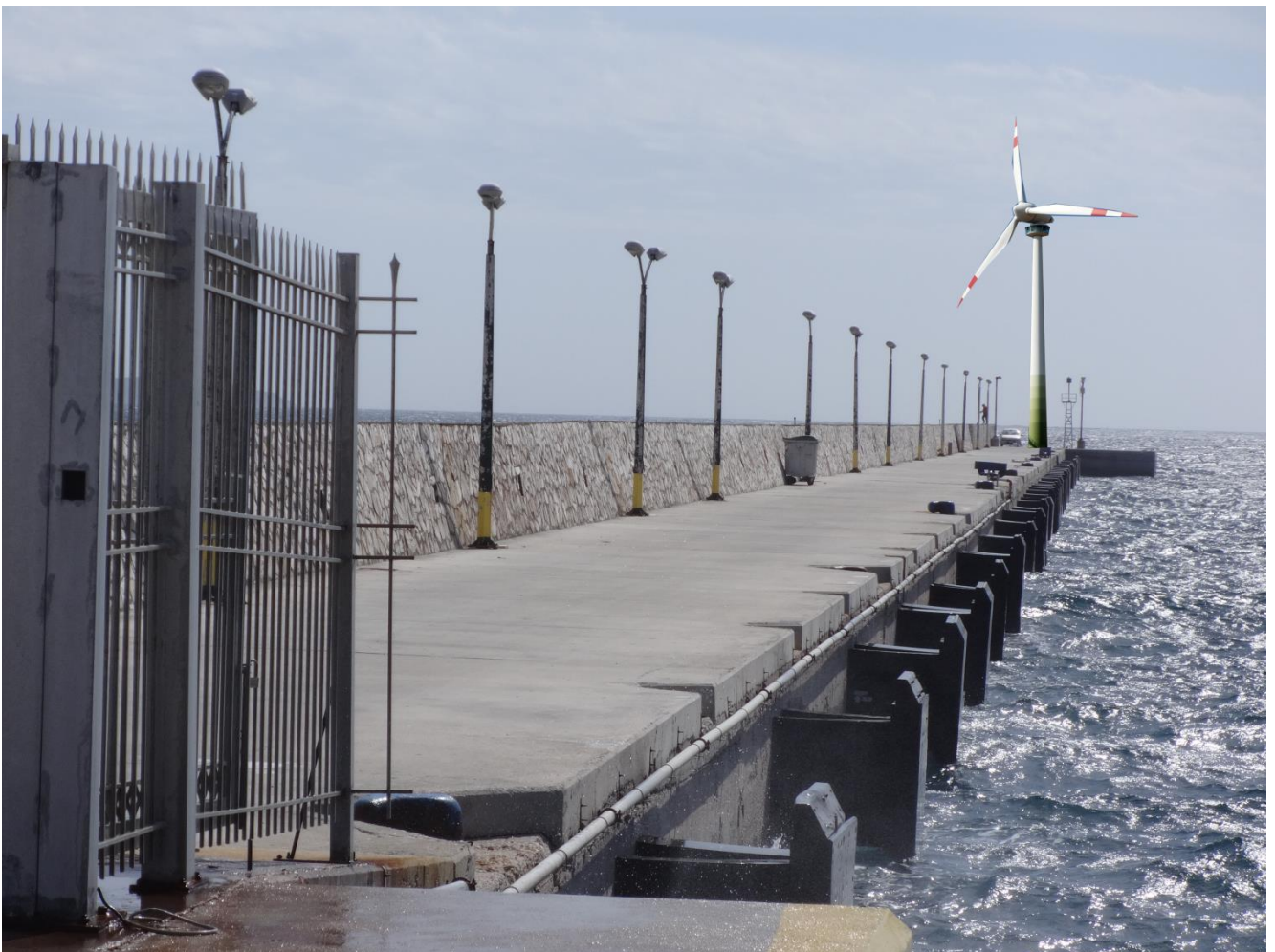
{Εικ. 3.77} Ανεμογεννήτρια στο ακρομώλιο
