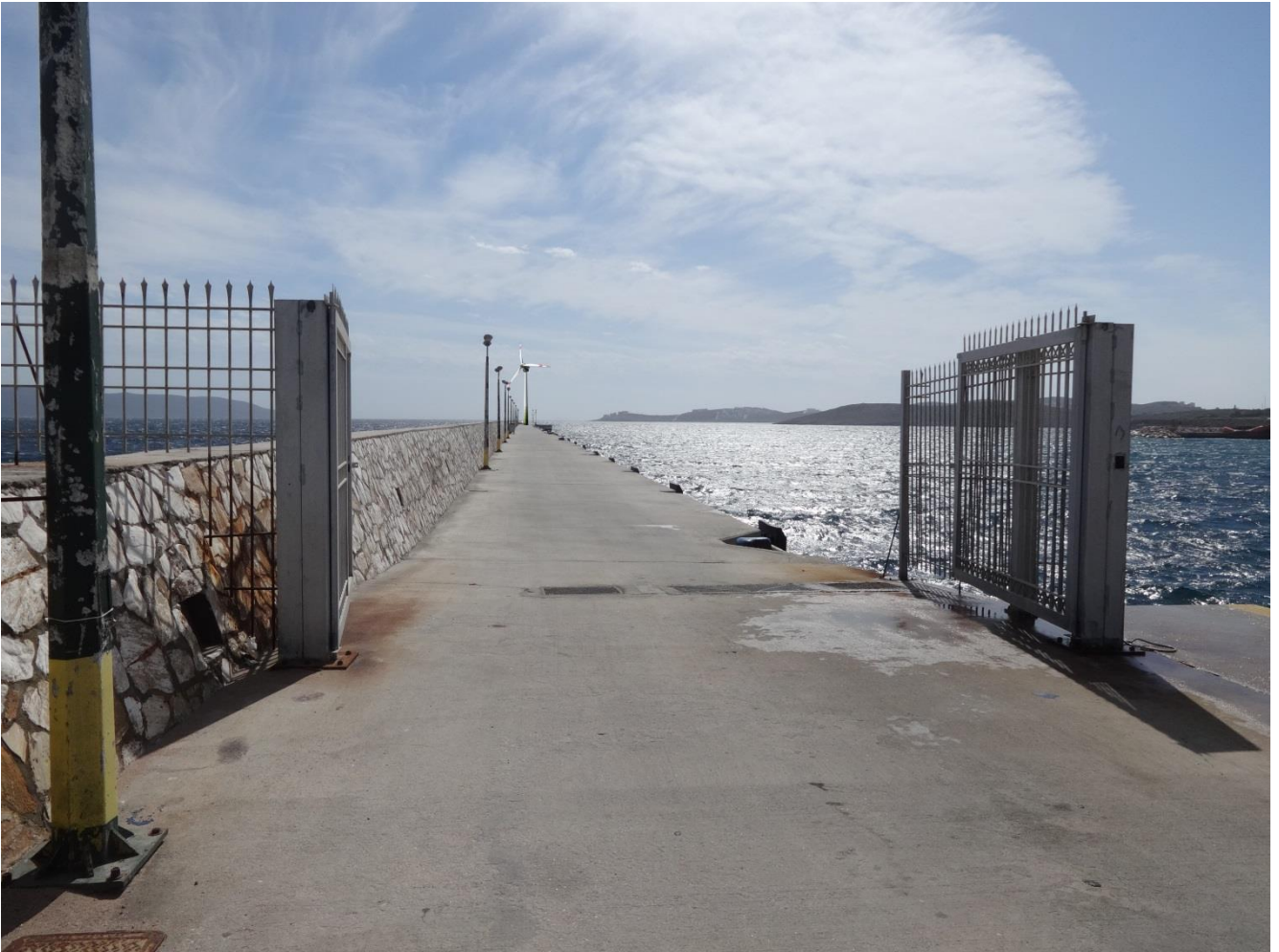
{Εικ. 3.78} Ανεμογεννήτρια στο ακρομώλιο
