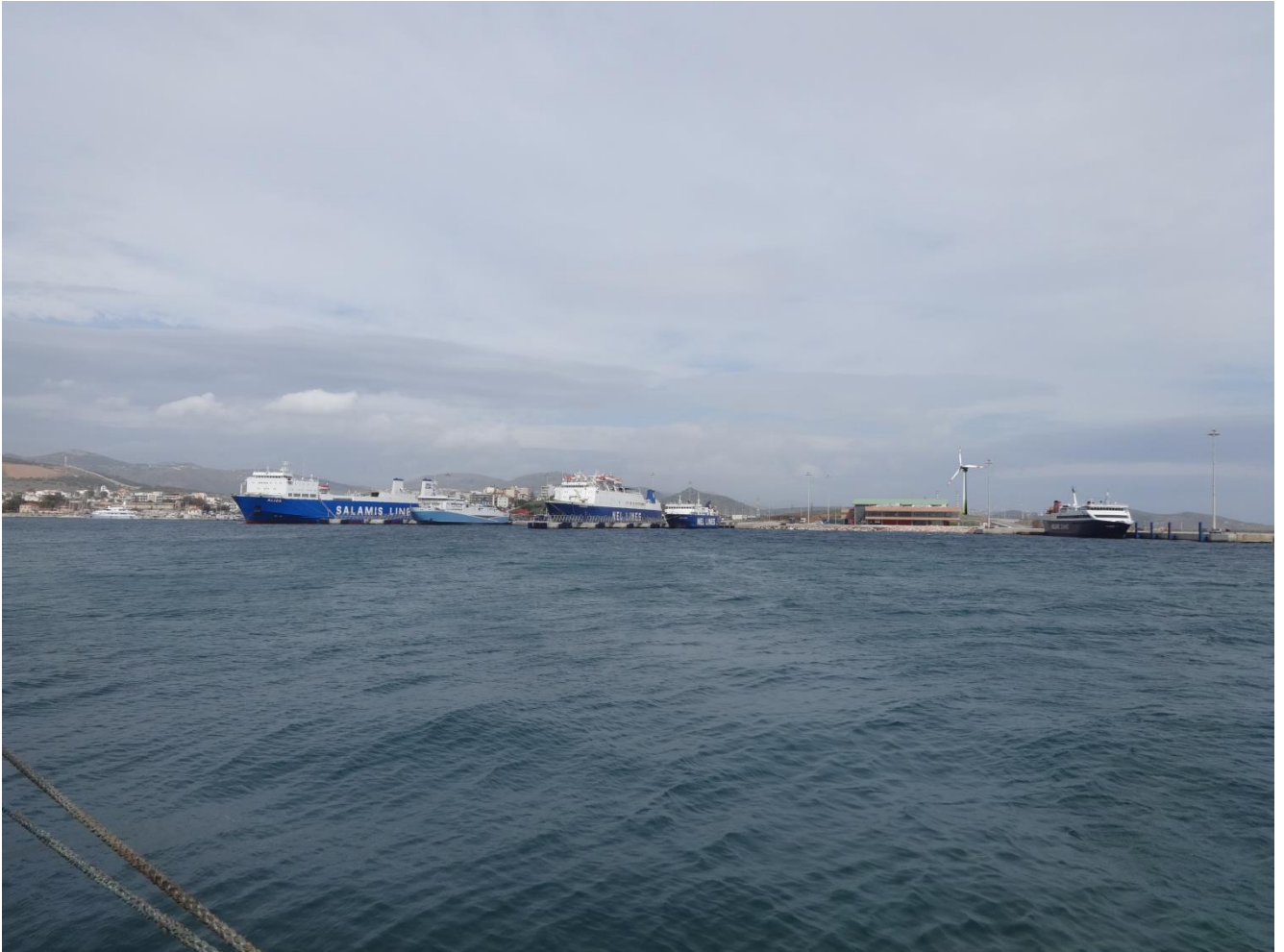
{Εικ. 3.88} Ανεμογεννήτρια και τοπίο λιμένας Λαυρίου
