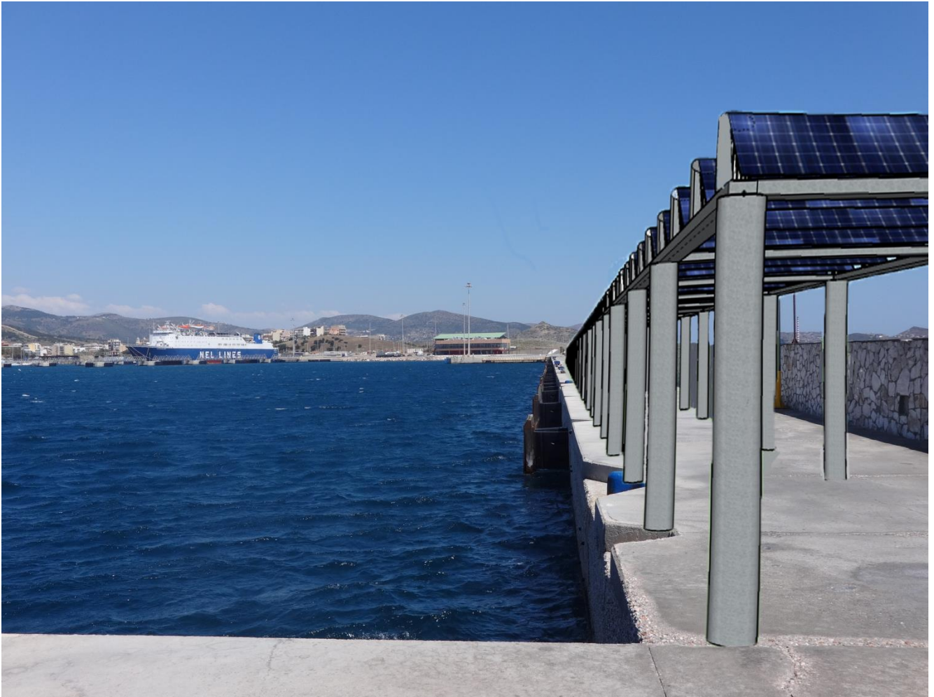
{Εικ. 3.27} Ακρομόλιο με τα προτεινόμενα Φ/Β πλαίσια
