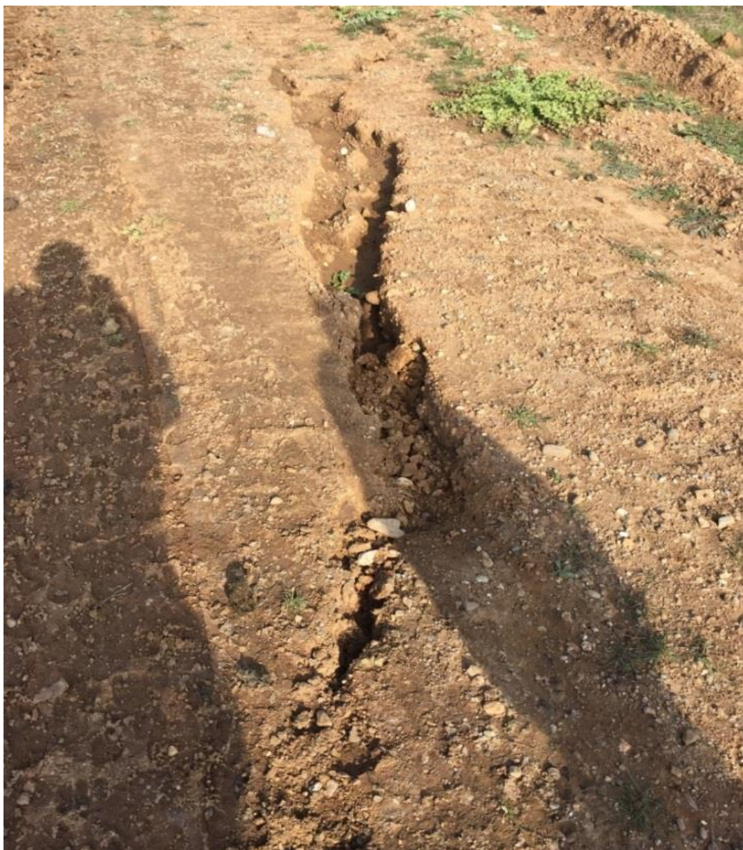
Εικόνα 4.4: Η ρωγμή στη στέψη του τεχνητού ορύγματος (φράγματος) του Αλφειού ποταμού.
