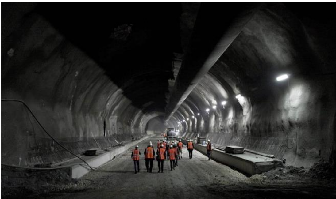
Εικόνα 2. Χρήση ινοπλισμένου σκυροδέματος για υποστήριξη σηράγγων
