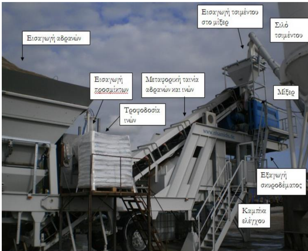
Εικόνα 5. Τροφοδοσία ινών στο παρασκευαστήριο σκυροδέματος (ΤΕΡΝΑ, 2009)
