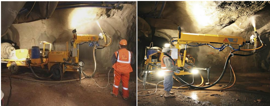
Εικόνα 10. Εκτόξευση ινοπλισμένου σκυροδέματος σε μεταλλευτικό έργο με Sika-PM 407 P
