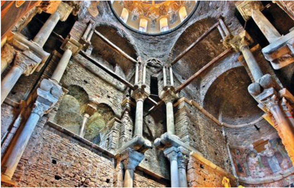
Εικόνα 3.11: Σύστημα στήριξης κεντρικού τρούλου.
