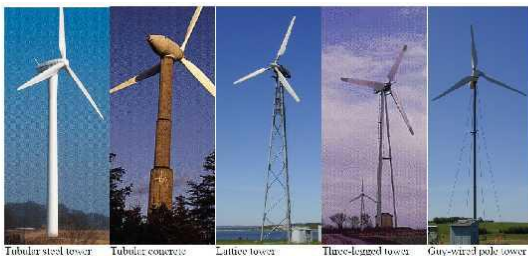
Σχήμα 1.16 Διαφορετικοί σχεδιασμοί πύργων ανεμογεννήτριας
