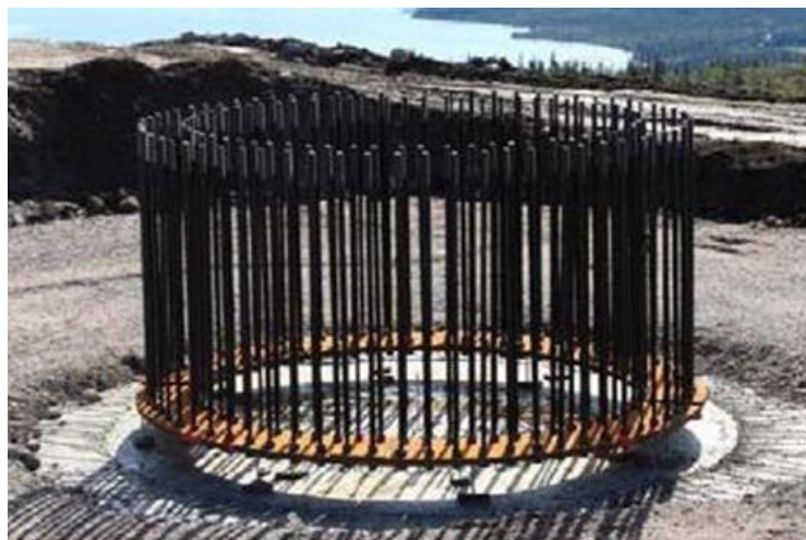
Σχήμα 1.11 Μορφή θεμελίωσης με αγκύρια υψηλής αντοχής
