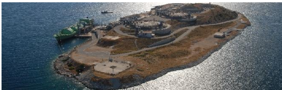
Εικόνα 21: Ο τερματικός σταθμός της Ρεβυθούσας (ιστοσελίδα ΔΕΣΦΑ)
