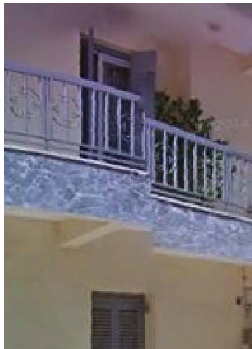
Εικόνα 4.23: Μεγέθυνση σε ασυνέχεια της εικόνας 2 (εικ2).
