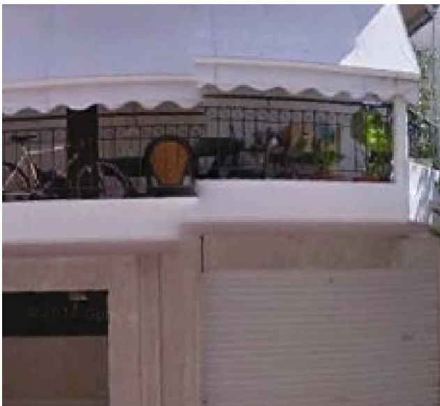
Εικόνα 4.22: Μεγέθυνση σε ασυνέχεια της εικόνας 2 (εικ2).
