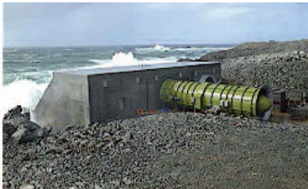
Εικόνα 1.6: Ο εγκατεστημένος σταθμός παραγωγής στο νησί Islay, Outer Hybrides, Σκωτία. (Πηγή: www.wikipedia.com )
