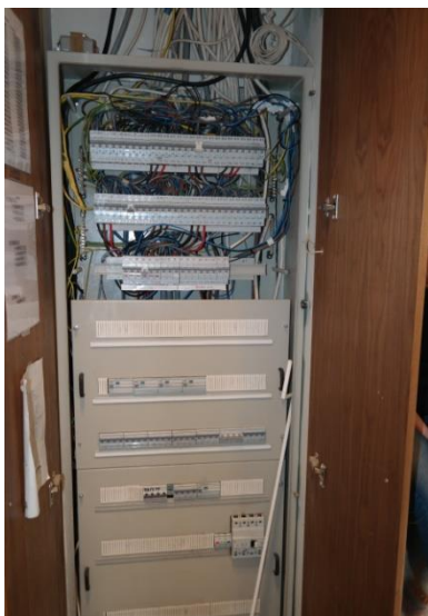
Εικόνα 3.16: Κεντρικός Πίνακας
