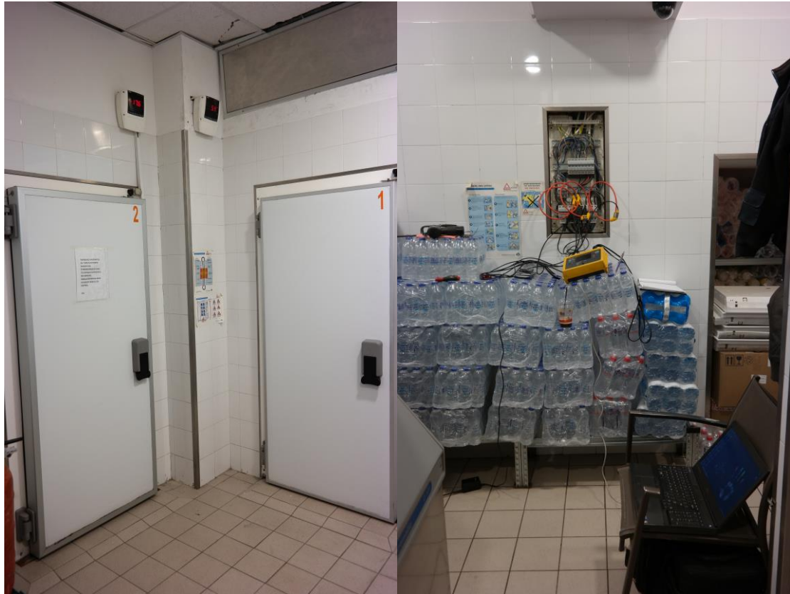
Εικόνα 3.40: (α) Πόρτες ψυγείων με τους μετρητές εσωτερικής θερμοκρασίας (β) Κατά τη συλλογή μετρήσεων
