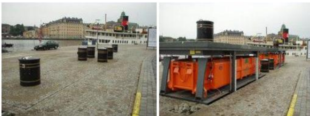
Εικόνα 10 Υπόγειος υδραυλικός συμπίεστής στην κανονική θέση και στην θέση εκκένωσης
