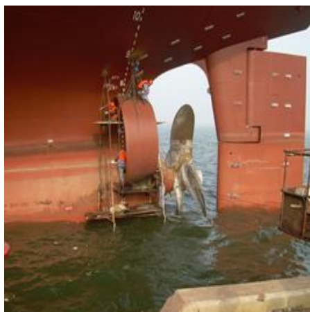
Σχήμα 8.4: Τοποθέτηση του δακτυλίου εξισορρόπησης ροής σε θαλάσσια επισκευή
