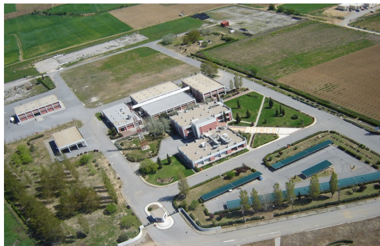
Εικόνα 12 : Κέντρο Λειτουργίας και Συντήρησης
