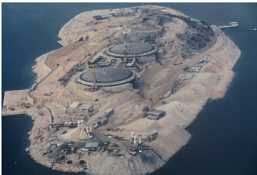
Εικόνα 18 : Εργασίες Αναβάθμισης στον Σταθμό LNG Πηγή: ΑΣΠΡΟΦΟΣ ΑΕ (2015)
