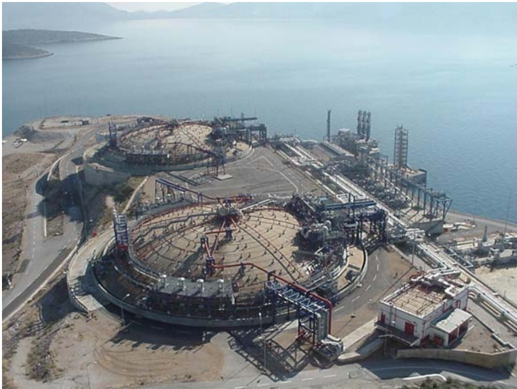
Εικόνα 15 : Σταθμός Υγροποιημένου Φυσικού Αερίου στη νήσο Ρεβυθούσα
