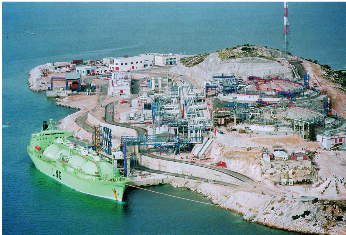
Εικόνα 17 : Ο Τερματικός Σταθμός Υγροποιημένου Φυσικού Αερίου (LNG)
