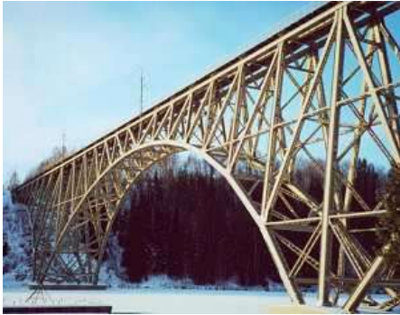
Εικόνα 1.11 (α) Γέφυρα Forsmo της Νορβηγίας
