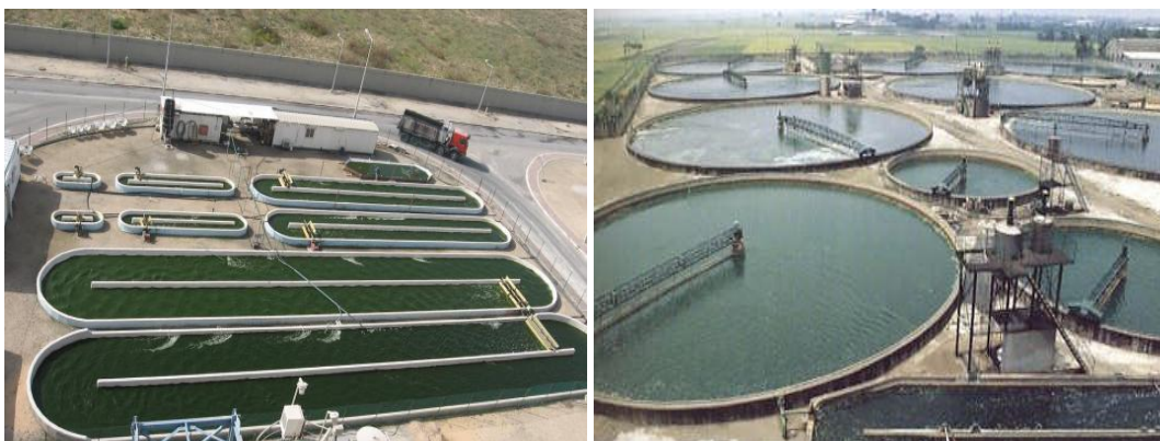
Εικόνα 5. Ανοικτού τύπου καλλιέργειες για την παραγωγή μικροφυκών (α. Τύπου raceway και β. Κυκλική)
