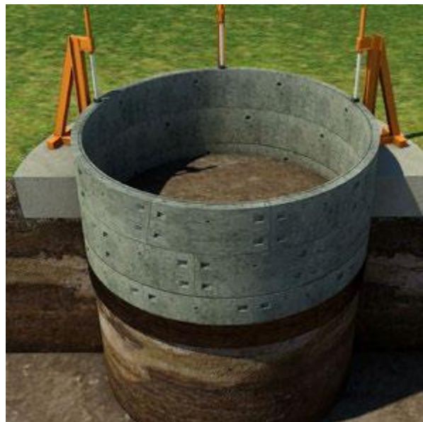
Εικόνα 1 : Διάνοξη και υποστήριξη φρέατος με την μέθοδο “Caisson”.
