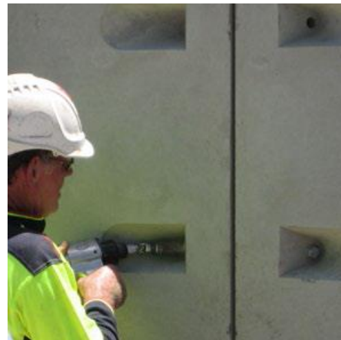
Εικόνα 5 : Τοποθέτηση κοχλιών στον οριζόντιο άξονα.
