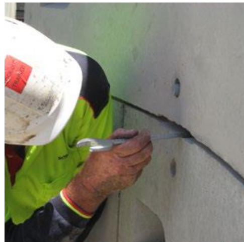
Εικόνα 5 : Τοποθέτηση κοχλιών στον οριζόντιο άξονα.
