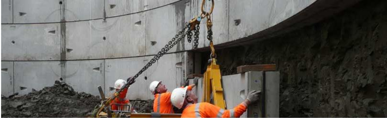
Εικόνα 7 : Τοποθέτηση προκατασκευασμένων στοιχείων προσωρινής υποστήριξης με την μέθοδο “Underpin”.
