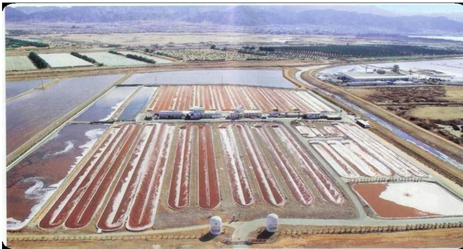
Εικόνα 2: Ανοιχτές δεξαμενές καλλιέργειας της άλγης Dunaliella με αναδευτήρες για καλύτερη ανακυκλοφορία του νερού
