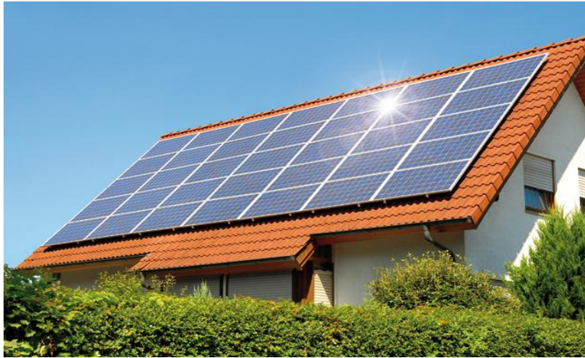
Εικόνα 2.4: Εγκατάσταση φωτοβολταϊκών σε στέγη [18]
