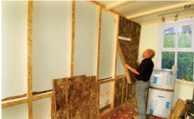
Εικόνα 1.2: Εσωτερική θερμομόνωση κτιρίου [7]
