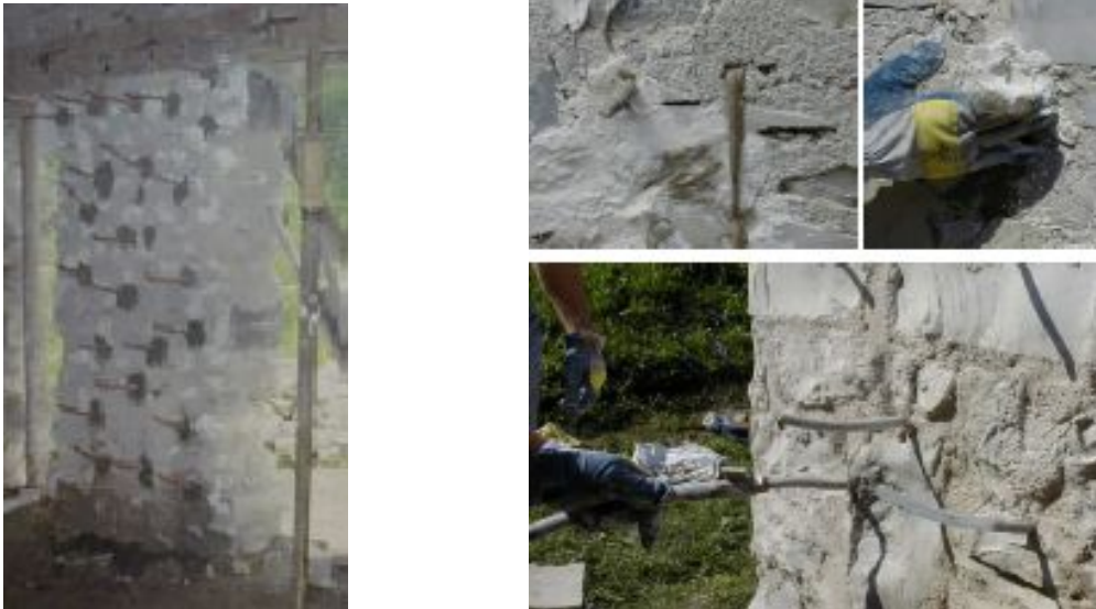
Εικόνα 3. Εφαρμογή ενεμάτων σε τοιχοποιία
