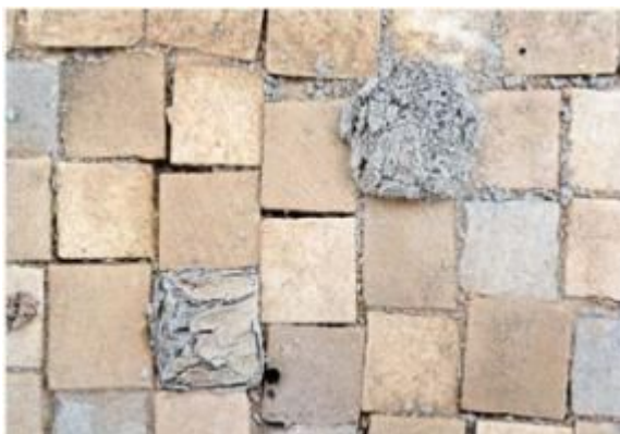
Εικόνα 12. Φθορά από κρυστάλλωση αλάτων στο πορώδες των ψηφίδων.
