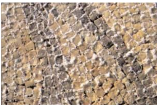
Εικόνα 11. Εξάνθιση αλάτων στα περατωτικά όρια ψηφίδων.
