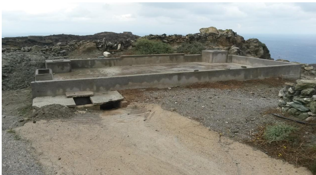
Εικ. 4.9: Αγροτική δεξαμενή συλλογής όμβριων νερών- Rain water harvesting
