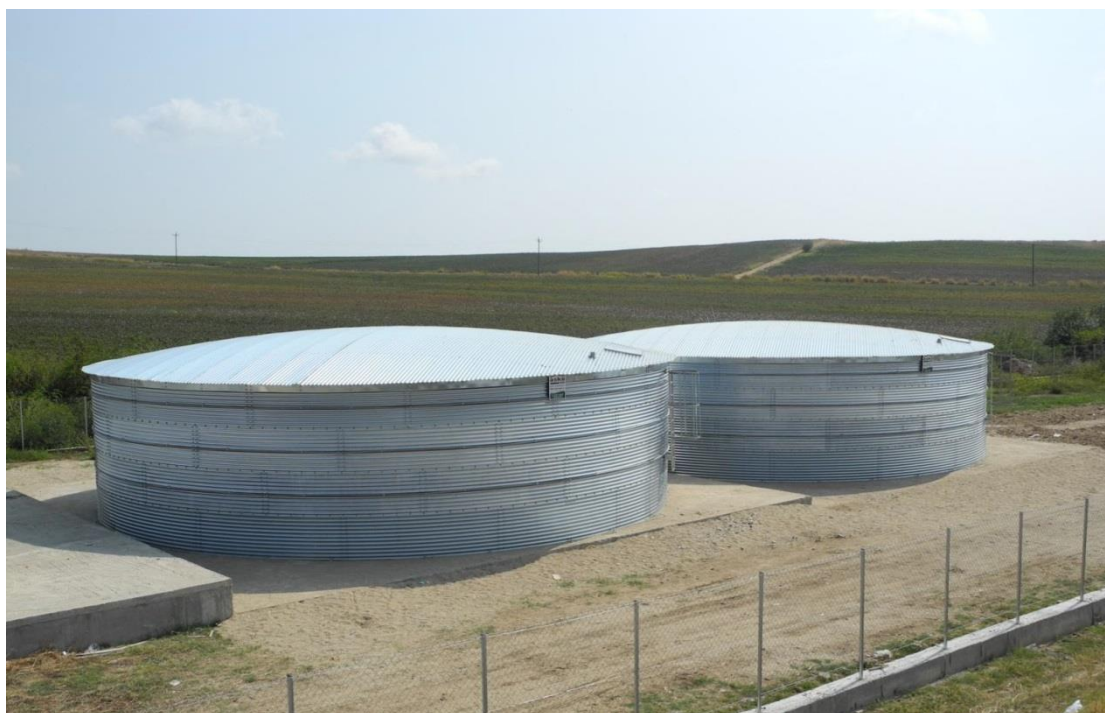
Εικ.6.4: Προκατασκευασμένες μεταλλικές δεξαμενές
