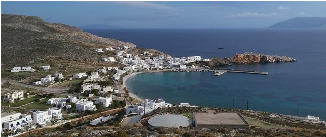
Εικ. 4.4: Πανοραμική άποψη Καραβοστάση- Δεξαμενές αποθήκευσης νερού
