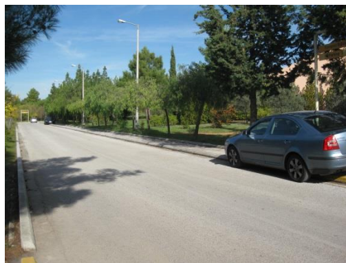
Εικόνα 2.12: Στάθμευση πάνω στο πεζοδρόμιο στο δρόμο που ενώνει το κτίριο Διοίκησης με το Θωμαΐδειο
