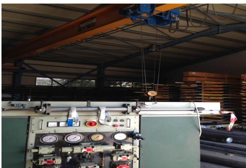
Εικόνα 3.31 Μετακίνηση της HERION με γερανογέφυρα μετά την ολοκλήρωση των εργασιών.
