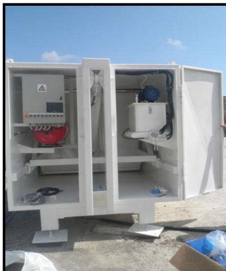
Εικόνα 41 Τμήμα 1<sup>ο</sup> μέρους του βιοαντιδραστήρα που περιλαμβάνει το θάλαμο του μηχανολογικού εξοπλισμού
