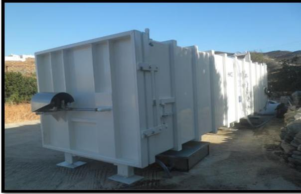
Εικόνα 49 Δεξαμενή συλλογής στραγγισμάτων, τοποθετημένη και συνδεδεμένη στο σημείο εξόδου των στραγγισμάτων
