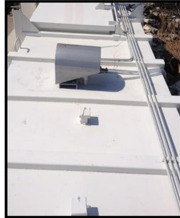
Εικόνα 46 Σωλήνες συστήματος ύγρανσης που διατρέχουν εξωτερικά το κέλυφος του βιοαντιδραστήρα.
