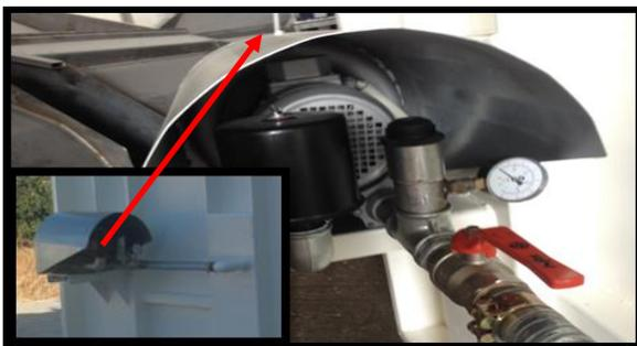
Εικόνα 43 Εξωτερικό τμήμα συστήματος αερισμού αποτελούμενο από (i) φυσητήρα, (ii) μανόμετρο, (iii) βαλβίδα που απολήγουν σε πλαστικό σωλήνα  $\Phi 50$  mm.
