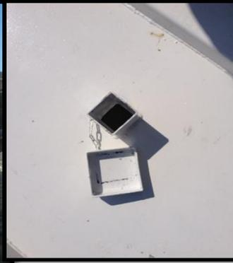
Εικόνα 50 Οπές δειγματοληψίας του 2<sup>ου</sup>, 3<sup>ου</sup> και 4<sup>ου</sup> τμήματος του βιοαντιδραστήρα
