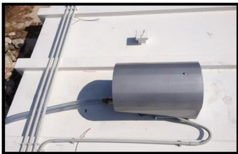
Εικόνα 47 Διάταξη αναρρόφησης αέρα από το εσωτερικό του βιοαντιδραστήρα, αποτελούμενη από (i) φυσητήρα, (ii) μανόμετρο, (iii) βαλβίδα που απολήγουν σε πλαστικό σωλήνα Φ50 mm.
