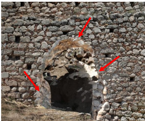
Εικόνα 5-21: Ορθοεικόνα: προβλήματα στην υφή λόγω εικόνων διαφορετικής φωτεινότητας.
