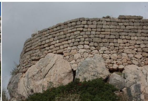
Εικόνα 2-13: Νότια πλευρά των τειχών-προσιτή
