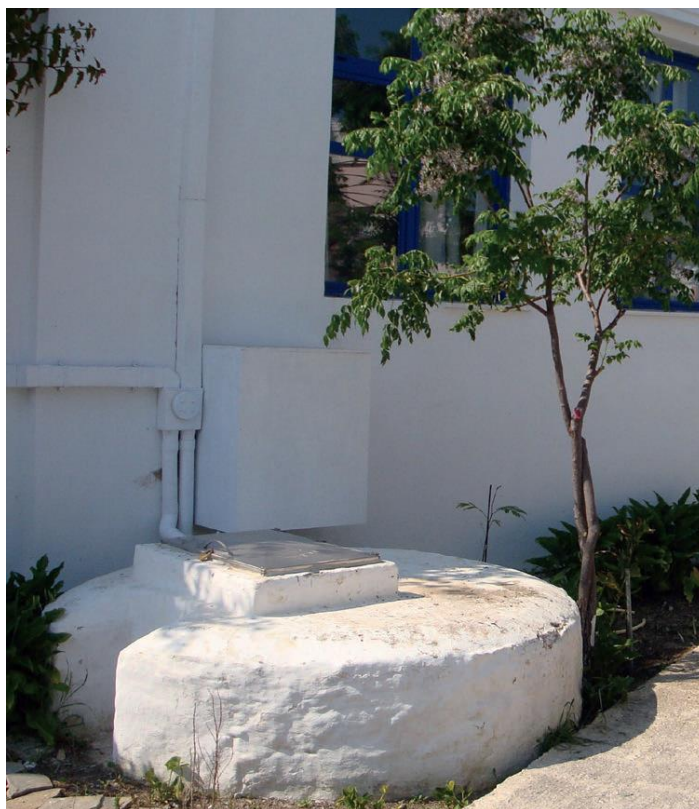
Εικόνα 3.4 Εξωτερική χτιστή στέρνα στη Σύρο © Θώμη Βλαχογιάννη
