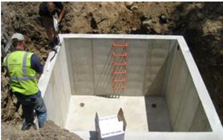
Εικόνα 3.11 Υπό κατασκευή υπόγεια τσιμεντένια δεξαμενή αποθήκευσης όμβριων υδάτων με σύστημα πρόσβασης (Πηγή: http://durabuildcare.com/images/underground-water-tank.jpg )
