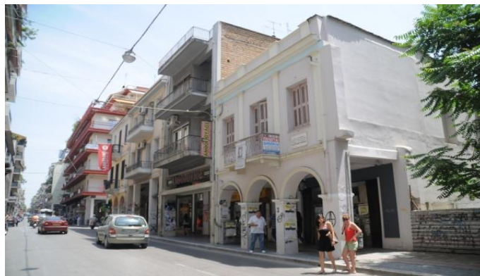
Εικόνα 7-Ένα παράδειγμα στοάς κτιρίου πάνω από πεζοδρόμιο στην οδό Κορίνθου στη Πάτρα. (Πηγή: patratora.gr, 2015)
