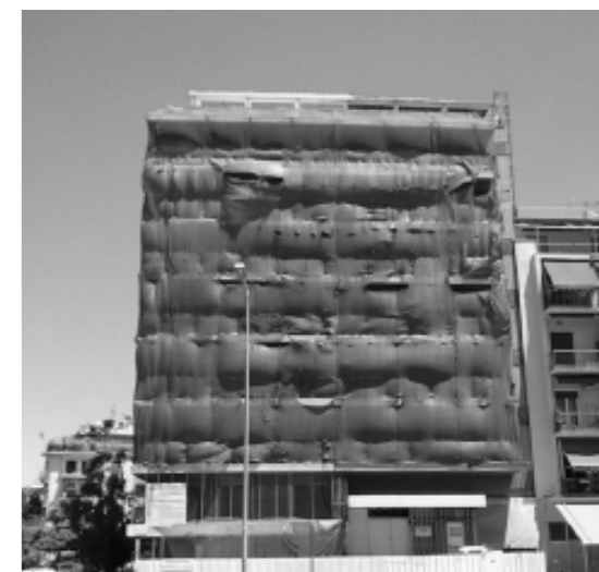
07_ Εστία Παντείου Πανεπιστήμιου (υπό επισκευή)
