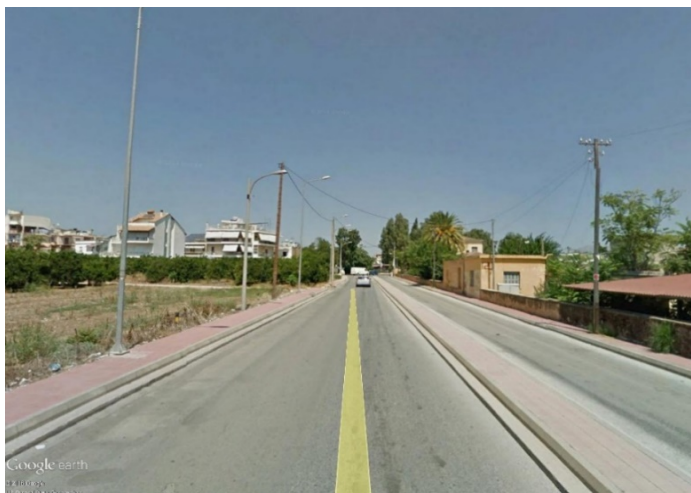
Εικόνα 5.8: Υφιστάμενη Κατάσταση της Οδού 25ης Μαρτίου (Άργος) Πηγή: Google Earth StreetView, 2014
