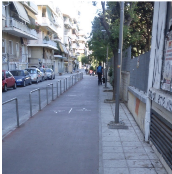
Εικόνα 6.4: Παράδειγμα Διαμόρφωσης Ποδηλατόδρομου στο Ύψος του Πεζοδρομίου με Δάπεδο Corridol στα Πετράλωνα Πηγή: Προσωπικό Αρχείο, 2016
