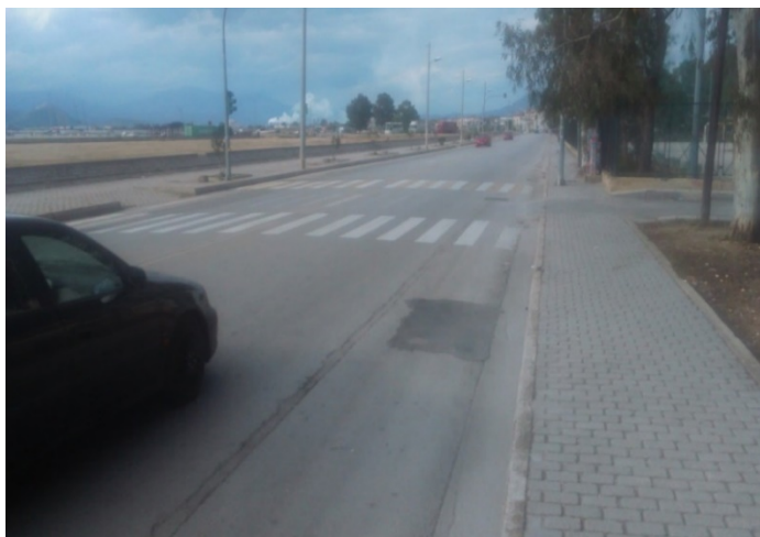
Εικόνα 5.14: Υφιστάμενη Κατάσταση της Παραλιακή Οδού (1) (Ναύπλιο) Πηγή: Προσωπικό Αρχείο, 2016
