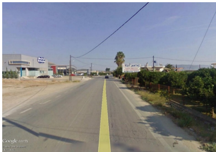
Εικόνα 5.17: Υφιστάμενη Κατάσταση της Επαρχιακής Οδού Νέας Κίου-Αργους (Ενδιάμεση Περιοχή)
