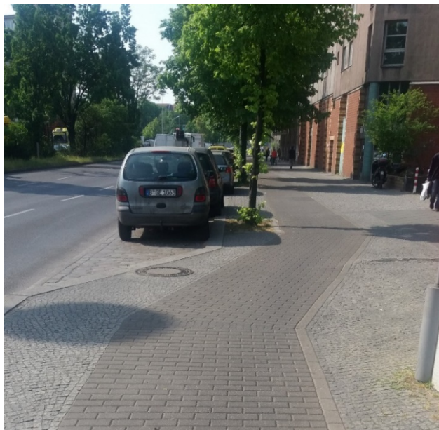
Εικόνα 6.5: Παράδειγμα Ποδηλατόδρομου με Κόκκινους Κυβόλιθους στο Βερολίνο Πηγή: Προσωπικό Αρχείο, 2016
