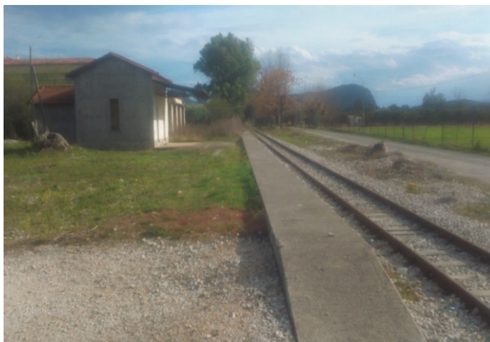
Εικόνα 5.10: Υφιστάμενη Κατάσταση στο Σταθμό ΟΣΕ της Τίρυνθας Πηγή: Προσωπικό Αρχείο, 2016
