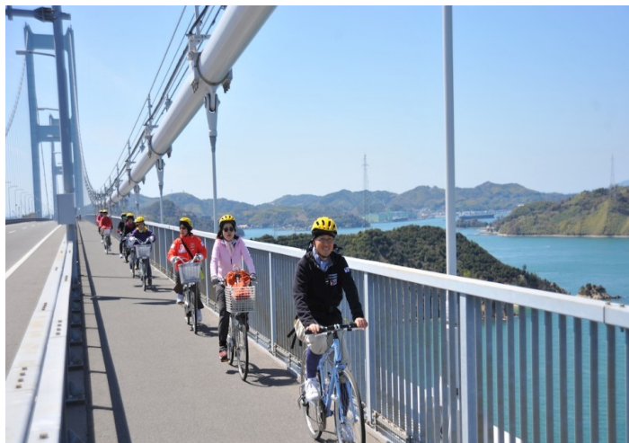
Εικόνα 5.6: Παράδειγμα Γέφυρας με Ποδηλατόδρομο στην Ιαπωνία Πηγή: www.cnn.com , 2015
