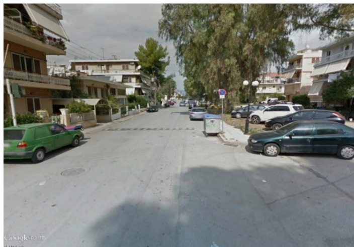
Εικόνα 5.2: Υφιστάμενη Κατάσταση της Οδού Αγίου (2) (Ναύπλιο) Πηγή: Google Earth StreetView, 2014
