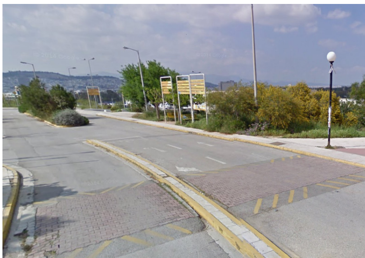
Εικόνα 6.8: Παράδειγμα Υπερυψωμένης Διάβασης στην Πολυτεχνειούπολη Ζωγράφου Πηγή: Προσωπικό Αρχείο, 2016
