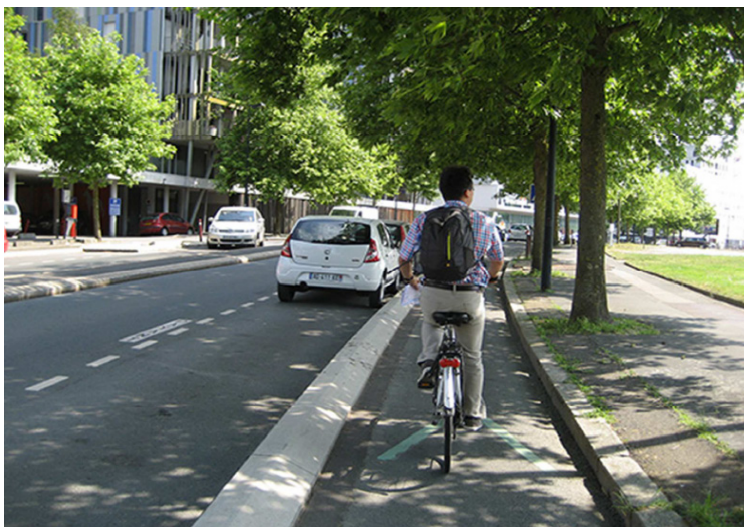
Εικόνα 6.1: Παράδειγμα Διαχωριστικού Πρόχυτου Κράσπεδου στη Ναντ της Γαλλίας Πηγή: Τεχνικές Οδηγίες για Υποδομές Ποδηλάτων, 2015
