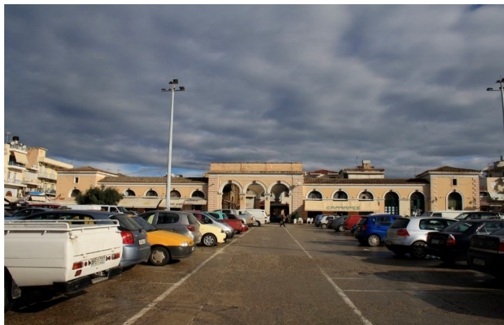
Εικόνα 3.13: Χώρος Στάθμευσης στο Χώρο της Λαϊκής Αγοράς στο Άργος Πηγή: www.blog.terrabook.com , 2015
