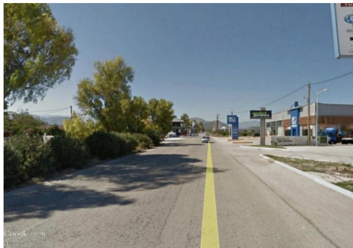
Εικόνα 5.5: Υφιστάμενη Κατάσταση της Εθνικής Οδού 70 (Περιοχή Δαλαμανάρας) Πηγή: Google Earth StreetView, 2014
