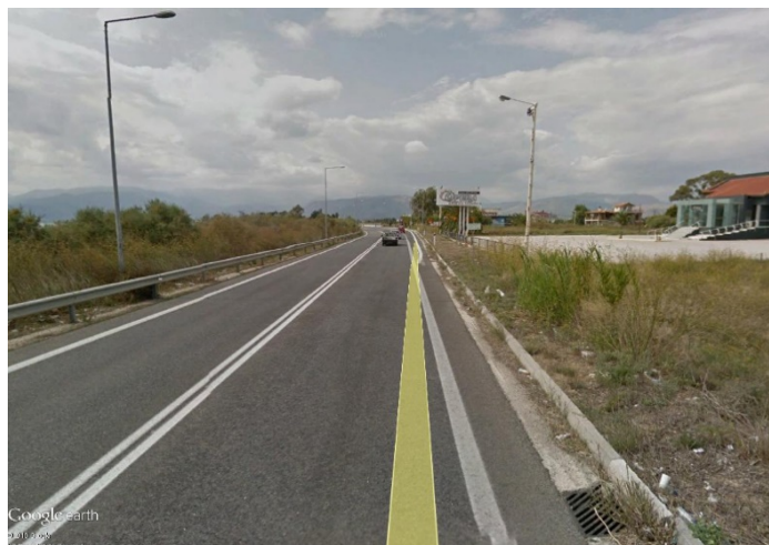
Εικόνα 5.15: Υφιστάμενη Κατάσταση της Παραλιακής Οδού (2) (Ενδιάμεση Περιοχή) Πηγή: Google Earth StreetView, 2014
