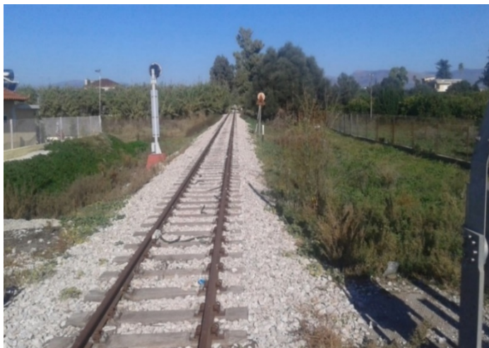
Εικόνα 5.4: Υφιστάμενη Κατάσταση των Σιδηροδρομικών Γραμμών (Περιοχή Τίρυνθα) Πηγή: Προσωπικό Αρχείο, 2015
