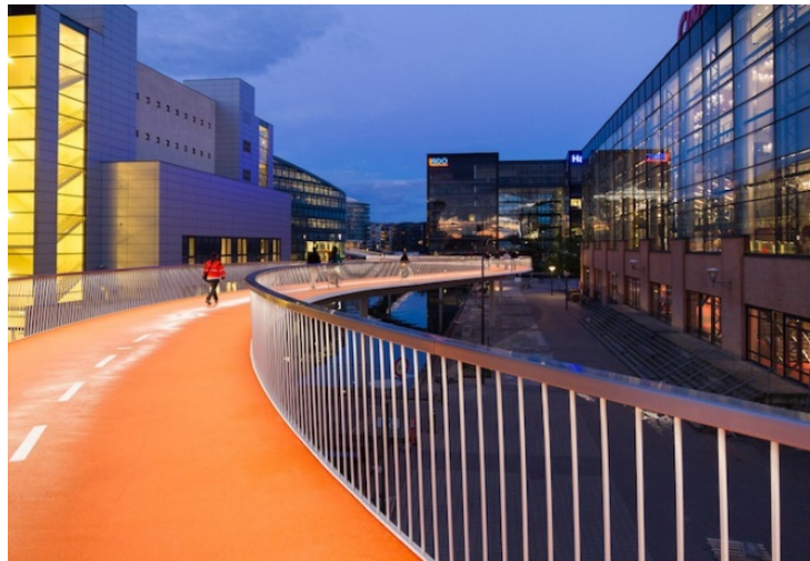
Εικόνα 6.9: Παράδειγμα Γέφυρας Ποδηλάτου στην Κοπεγχάγη Πηγή: www.wired.com , 2014
