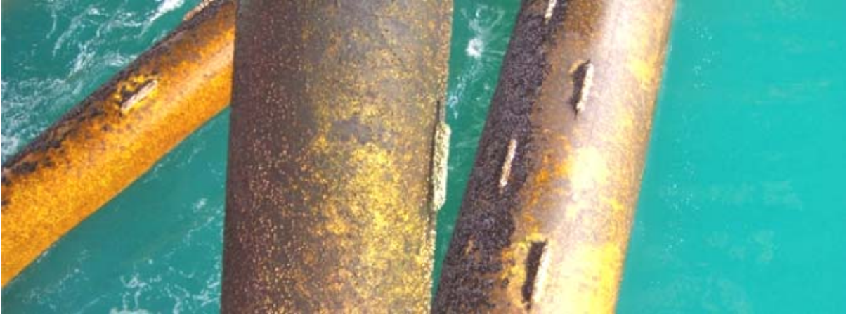
Σχήμα 3.6: Απεικόνιση θυσιαζόμενων ανόδων σε πλατφόρμα εξόρυξης πετρελαίου [37]
