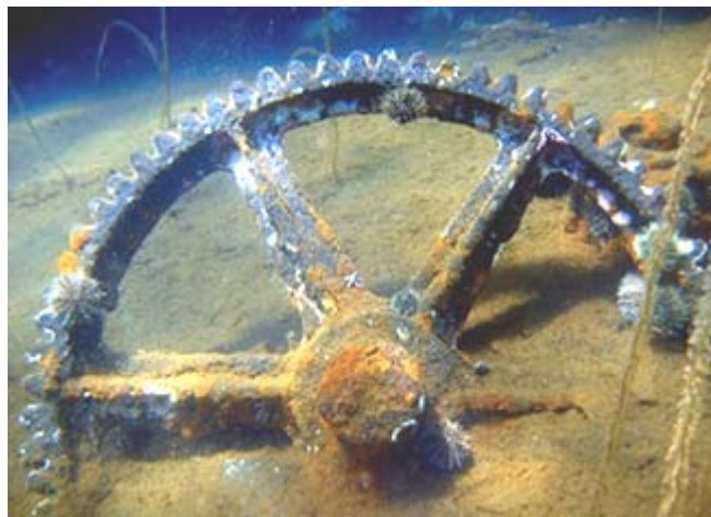
Σχήμα 1.3: Διάβρωση σε υδατικό περιβάλλον
