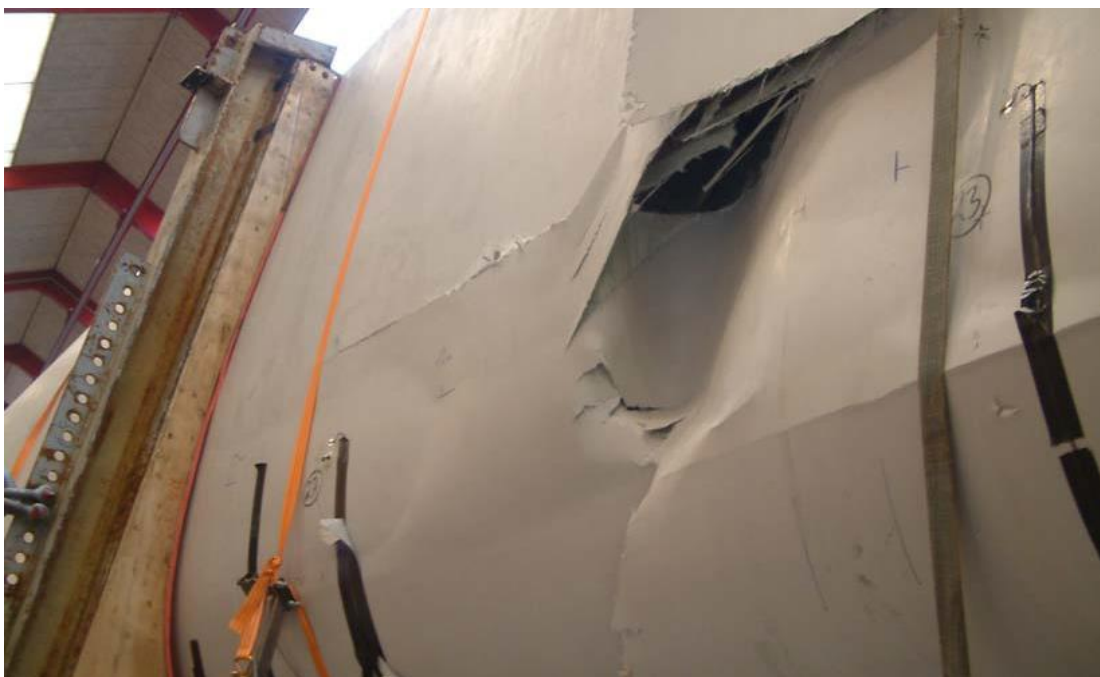
Σχήμα 4.1: Εκδήλωση τοπικού λυγισμού κατά την εκτέλεση πειράματος πλήρους κλίμακας [24]
