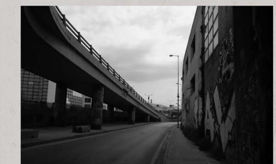
_άποψη γέφυρας Ομηρίδου Σκυλίτση
