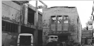
3_κτήριο καθαρισμού βαρελιών_1969
