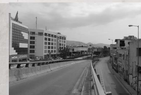
_άποψη οδού Ομηρίδου Σκυλίτση
