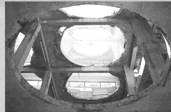
_εσωτερική λήψη_νέα σιλό αραβοσίτου
