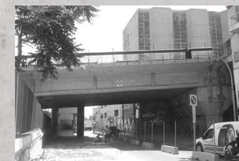
_άποψη οδού Ομηρίδου Σκυλίτση
