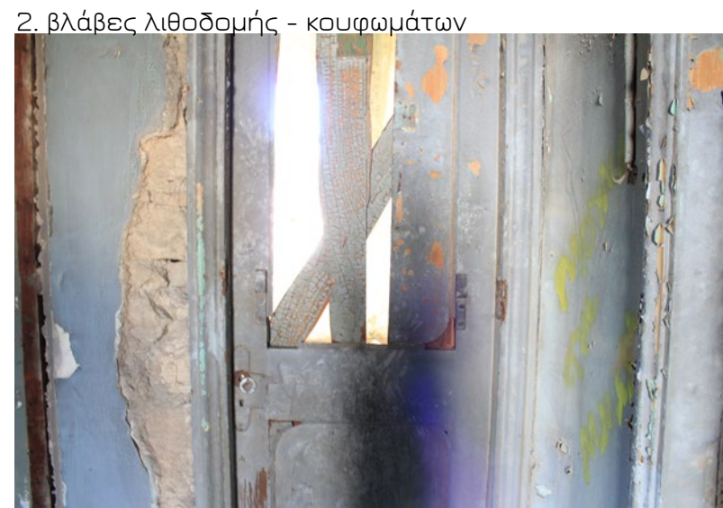
2. βλάβες λιθοδομής - κουφωμάτων
