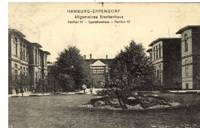
Eppendorf Hospital (1880-89), Αμβούργο, Zimmermann & Ruppel
