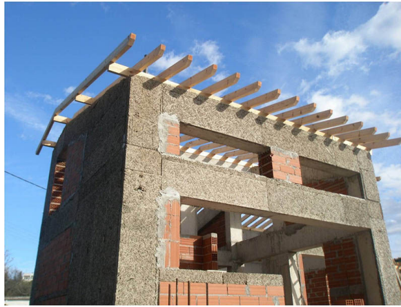
Εικόνα 11: Εξωτερική μόνωση σκελετού οπλισμένου σκυροδέματος με πλάκες ξυλόμαλλου
