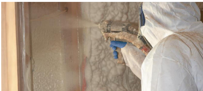
Εικόνα 8: Ψεκασμός αφρού πολυουρεθάνης
