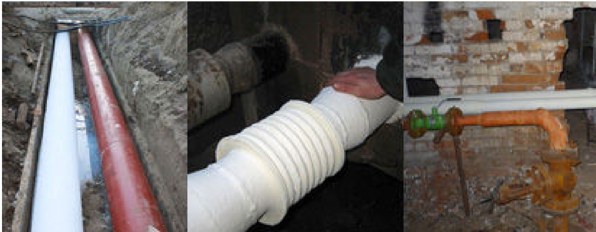
Εικόνα 31: Εφαρμογές μόνωσης σωληνώσεων με “Thermonassa I”
