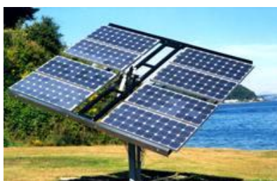
Εικόνα 3.19 : Σύστημα ιχνηλάτισης της πορείας του ηλίου.
