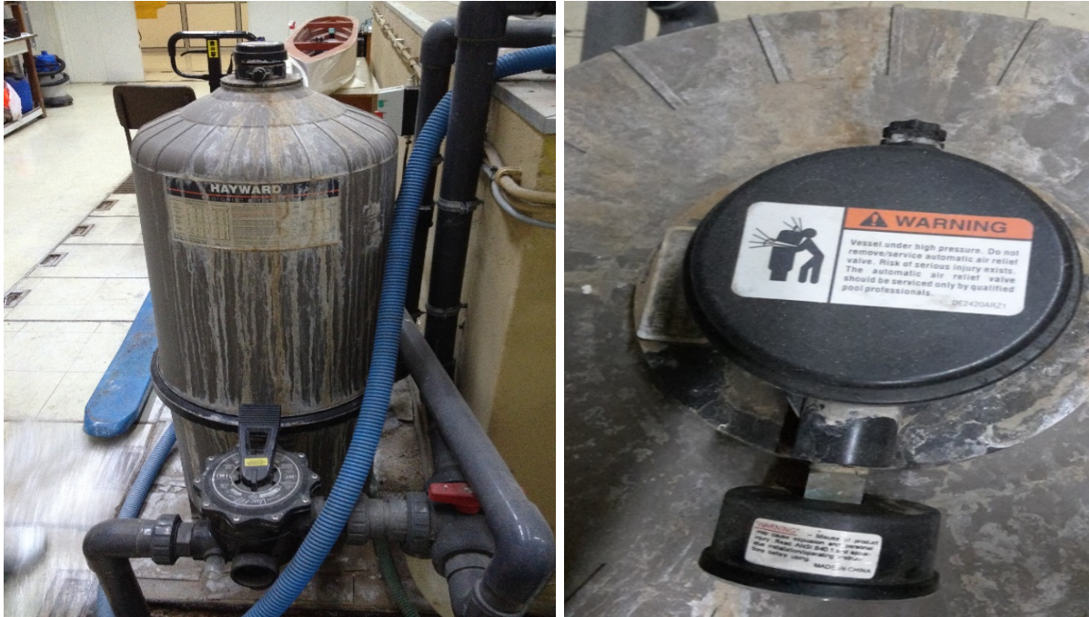
Εικόνα 3.11: Διατομικό φίλτρο δεξαμενής
