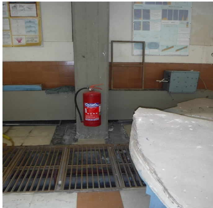
Εικόνα 4.35: Ορθή επιτοίχια ανάρτηση πυροσβεστήρα
