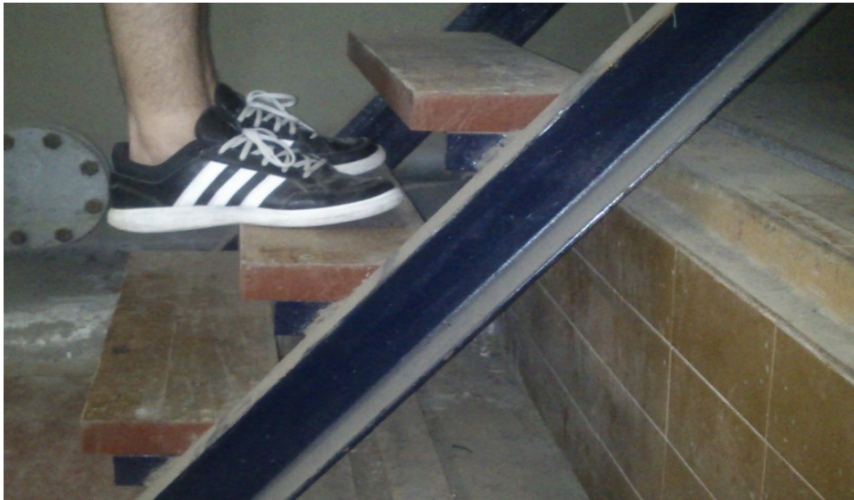
Εικόνα 4.8: Η σκάλα για την είσοδο στο δοκιμαστήριο των υδροδυναμικών μηχανών
