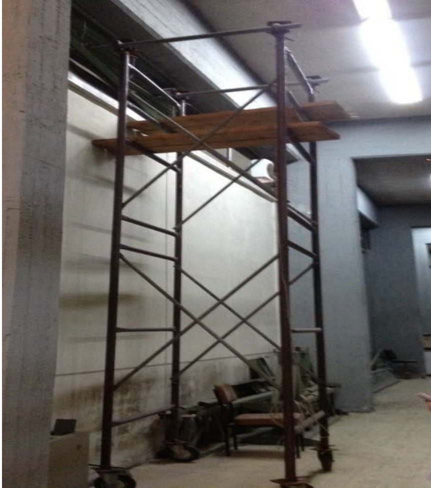
Εικόνα 3.9: αυτοσχέδιο ικρίωμα
