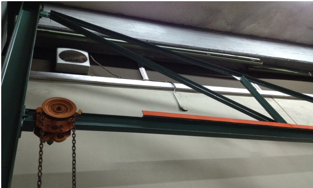
Εικόνα 3.3: Γερανός στο χώρο της δεξαμενής
