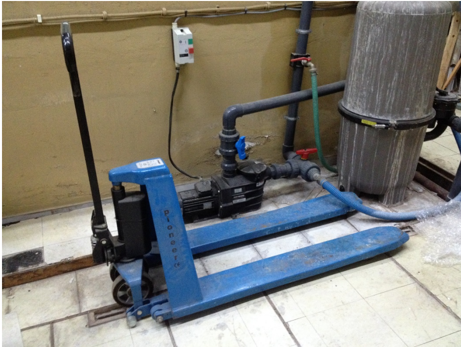
Εικόνα 3.6: Περονοφόρο ανυψωτικό μηχάνημα στο χώρο της δεξαμενής
