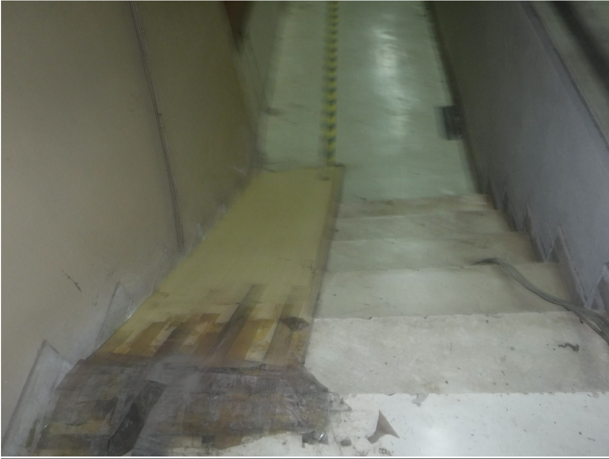
Εικόνα 3.29: Αυτοσχέδια ξύλινη ράμπα
