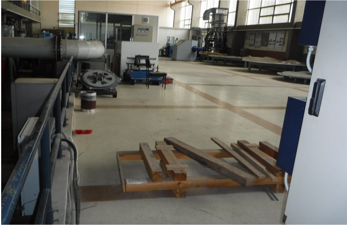
Εικόνα 4.2: Ξύλινες δοκοί στο δάπεδο του εργαστηρίου χωρίς λειτουργικό ρόλο ύπαρξης σε αυτή τη θέση.
