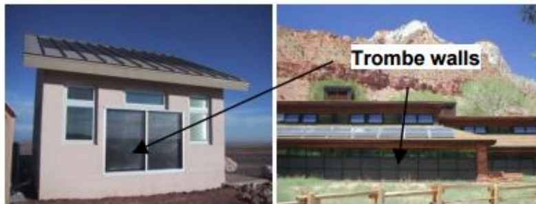
Εικόνα 1.7 Τοίχοι Trombe σε Κτήρια Χαμηλής Ενεργειακής Κατανάλωσης [15]
