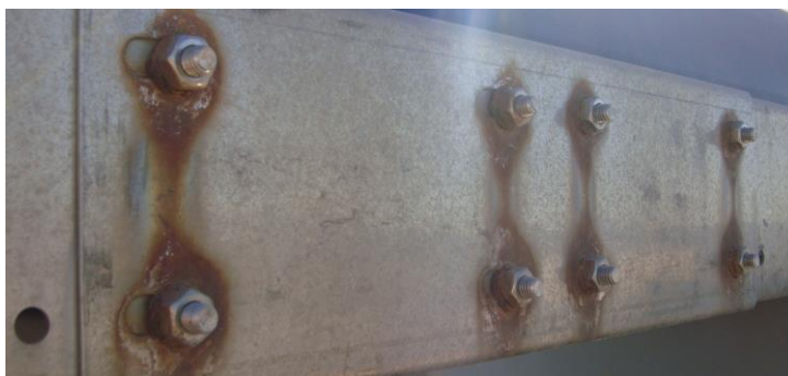
Εικόνα 5: Γαλβανική Διάβρωση
