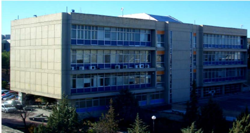
Εικόνα 51: Κτίριο Α Συγκροτήματος Γενικών Εδρών
