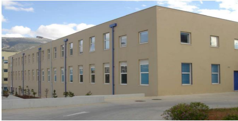
Εικόνα 40 : Κτίριο Τομέα Γεωτεχνικής Σχολής Πολιτικών Μηχανικών
