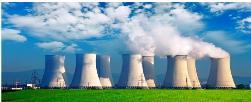
Εικ. 3: Πυρηνική Ενέργεια- Πυρηνικό εργοστάσιο (Πηγή: http://www.econews.gr/ )
