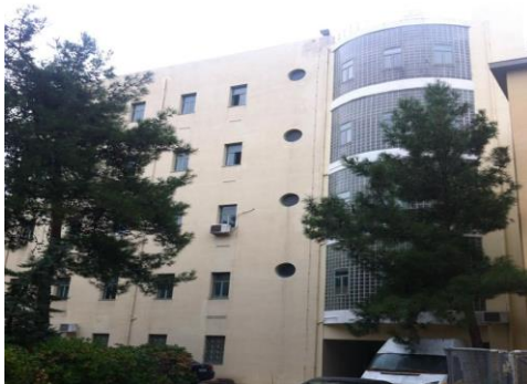
Εικόνα 41 : Κτίριο Διαχείρισης Τεχνικών Έργων Σχολής Πολιτικών Μηχανικών
