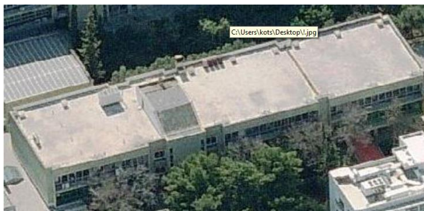
Εικόνα 52: Κτίριο Β Συγκροτήματος Γενικών Εδρών
