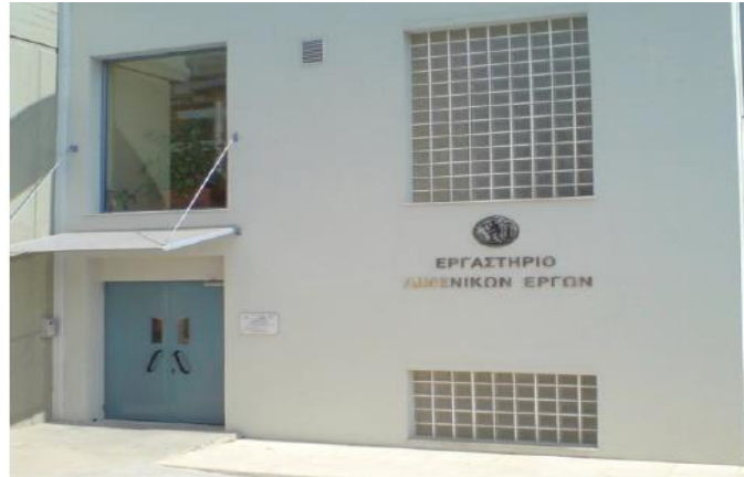
Εικόνα 46: Εργαστήριο Λιμενικών Έργων, Τμήμα Α
