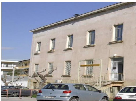
Εικόνα 42 : Κτίριο Οπλισμένου Σκυροδέματος Σχολής Πολιτικών Μηχανικών
