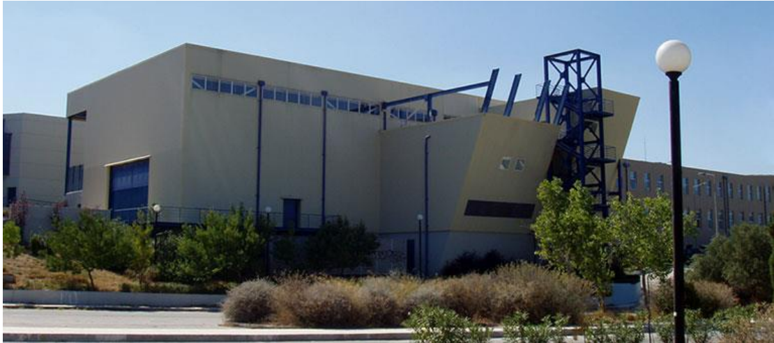
Εικόνα 38 : Εργαστήριο Μεταλλικών Κατασκευών Σχολής Πολιτικών Μηχανικών (Πηγή : http://labmetalstructures.civil.ntua.gr/cms/el/ )
